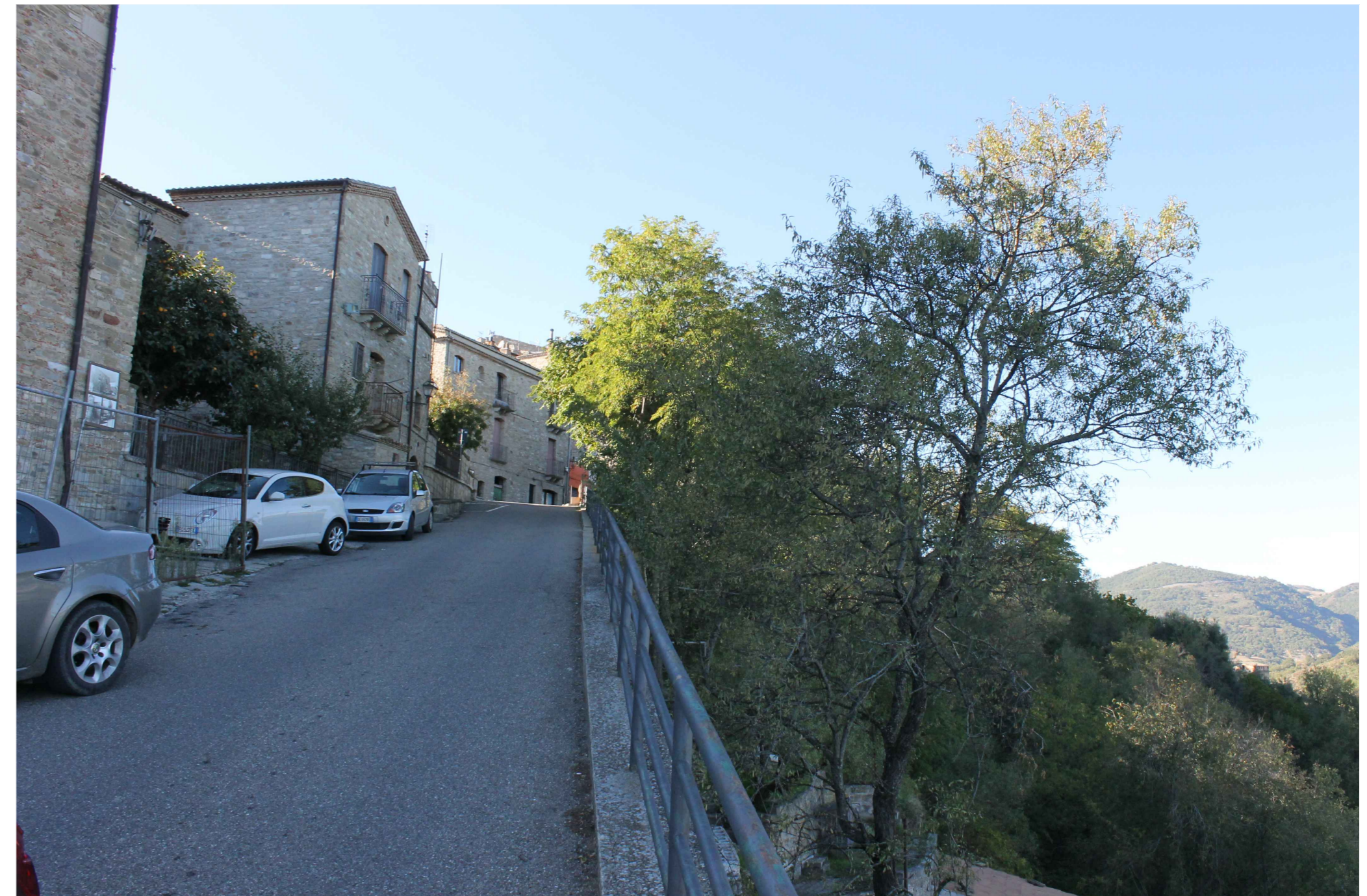
F10.GUARDIA PERTICARA - Strada interna al centro abitato: Fotosimulazione con parchi in fase di autorizzazione o autorizzati
