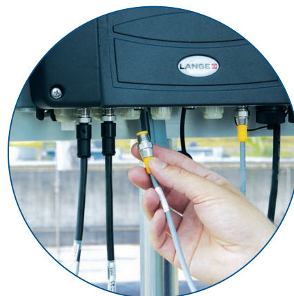
I nuovi sensori sono riconosciuti automaticamente
