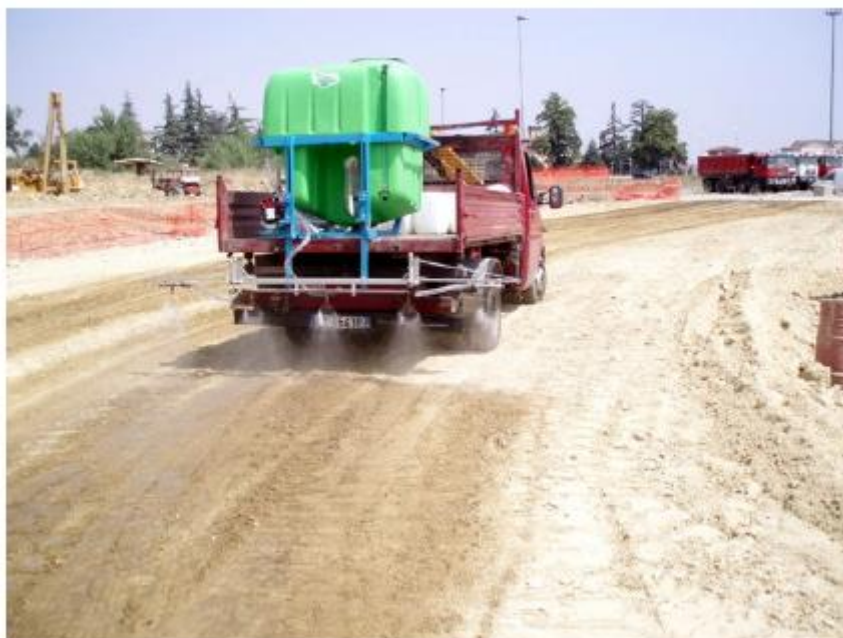
Bagnatura delle piste di cantiere
