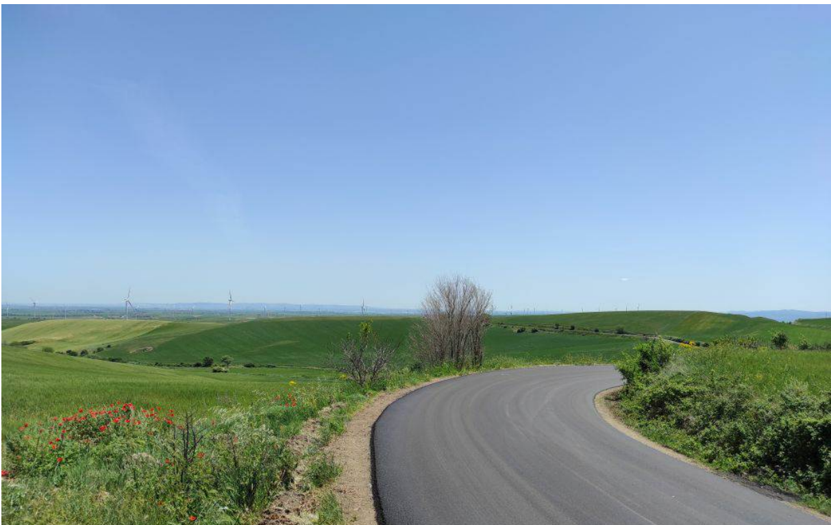
Foto P8.1: Vista della Strada Provinciale SP 90 (classifica di valenza paesaggistica nel PPTR), nel tratto interessato dal passaggio del cavidotto interno
