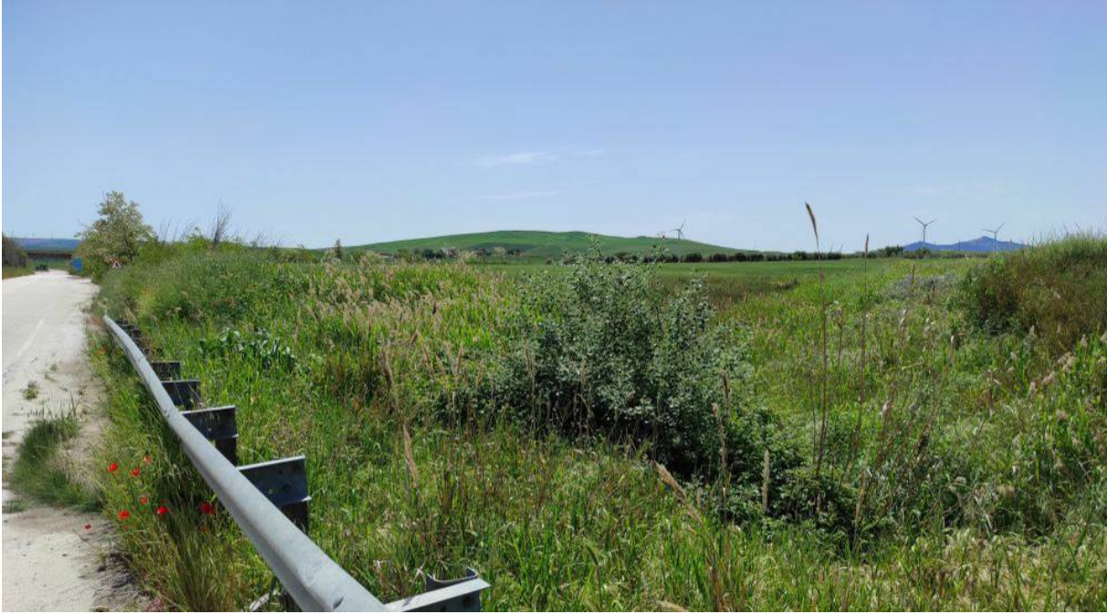
Foto P14.1: Vista del Fosso Viticone lungo la Strada Regionale SR1
