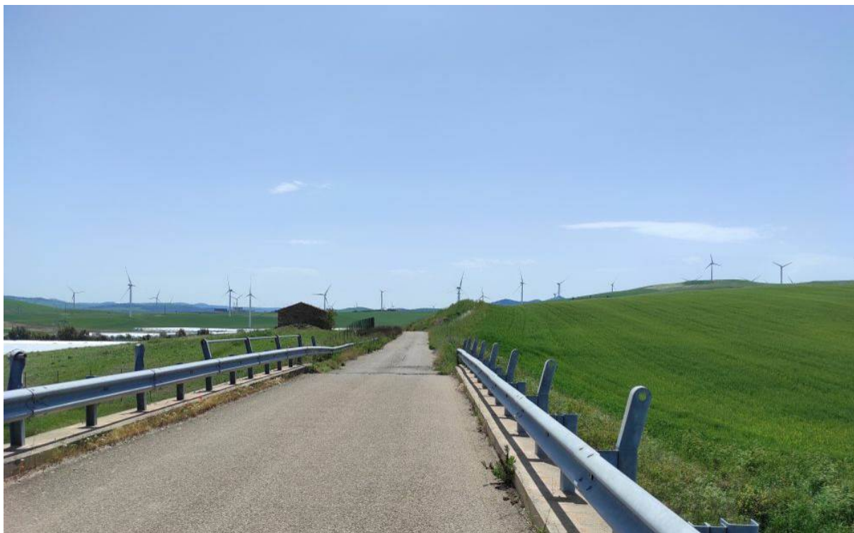
Foto P15.1: Vista in corrispondenza dell'attraversamento della SR1, lungo la strada secondaria di accesso all'area della stazione di Deliceto
