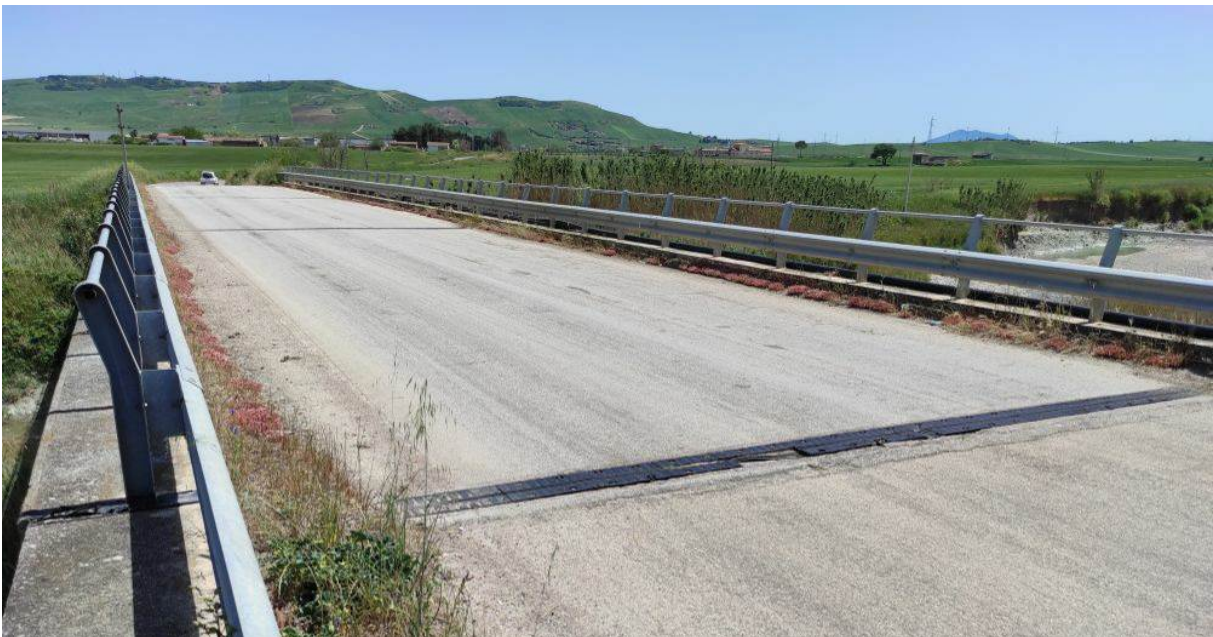
Foto P13.1: Vista lungo la Strada Provinciale SP 104, in corrispondenza dell'attraversamento del Torrente Carapelle nel tratto interessato dal passaggio del cavidotto esterno
