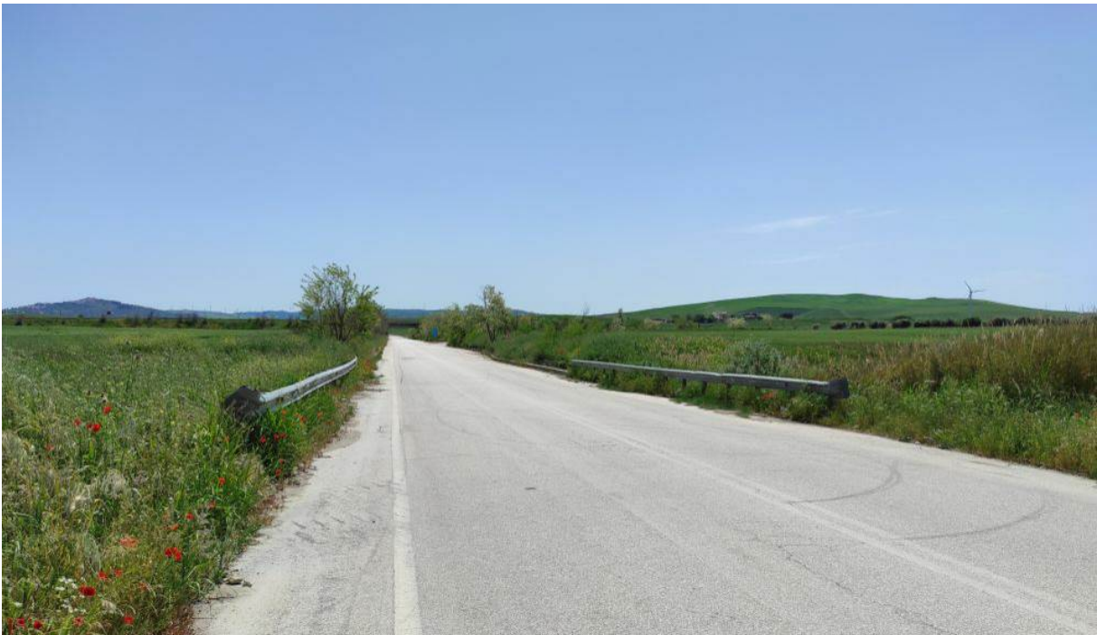
Foto P14.2: Vista lungo la Strada Regionale SR1, in corrispondenza dell'attraversamento del Fosso Viticole, nel tratto interessato dal passaggio del cavidotto esterno
