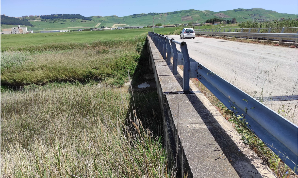
Il Torrente Carapelle, in direzione nord-ovest, in corrispondenza del ponte della SP104, interessato dal passaggio del cavidotto esterno
