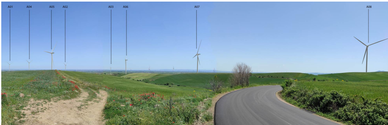
Vista V1_1 post operam - Vista verso Nord – Est
