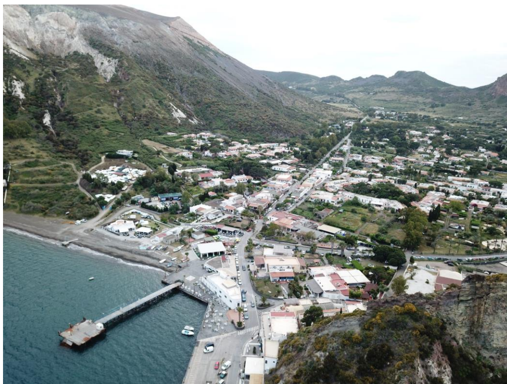
Figura 5-3 – Vista aerea dell'area di intervento ante operam
