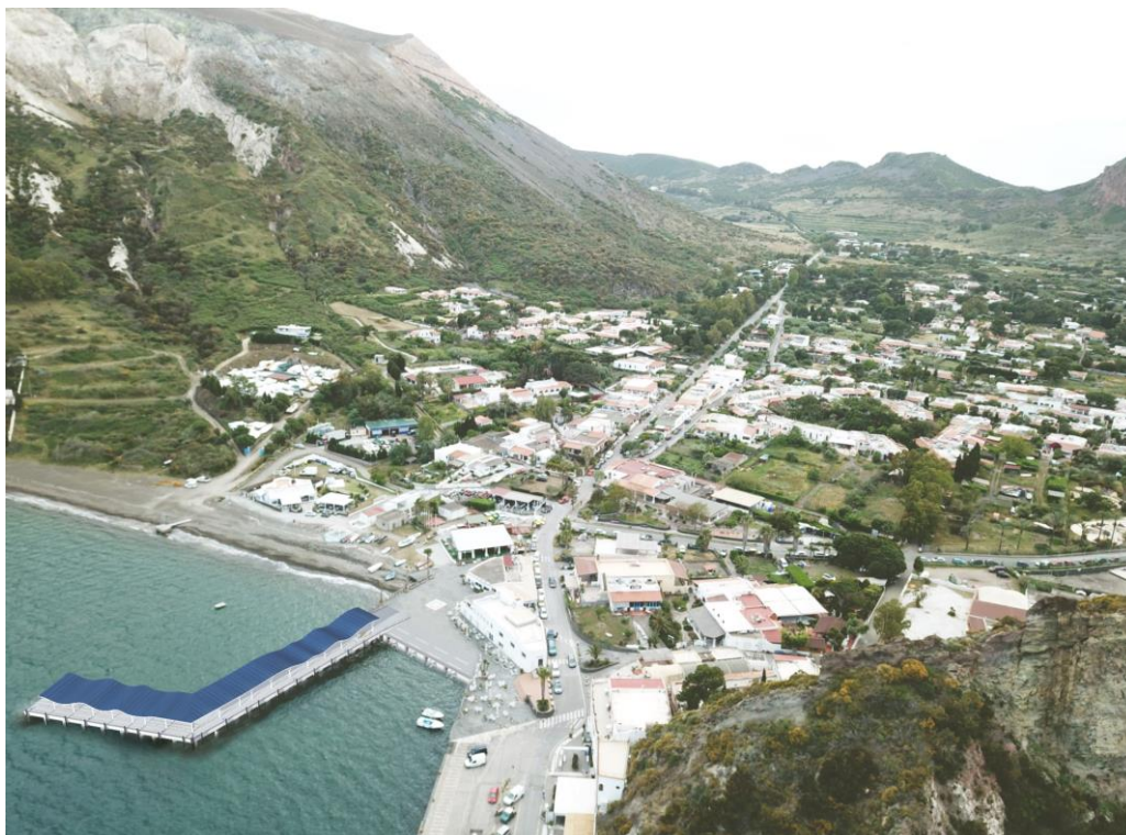
Figura 5-4 – Vista aerea dell'area di intervento post operam
