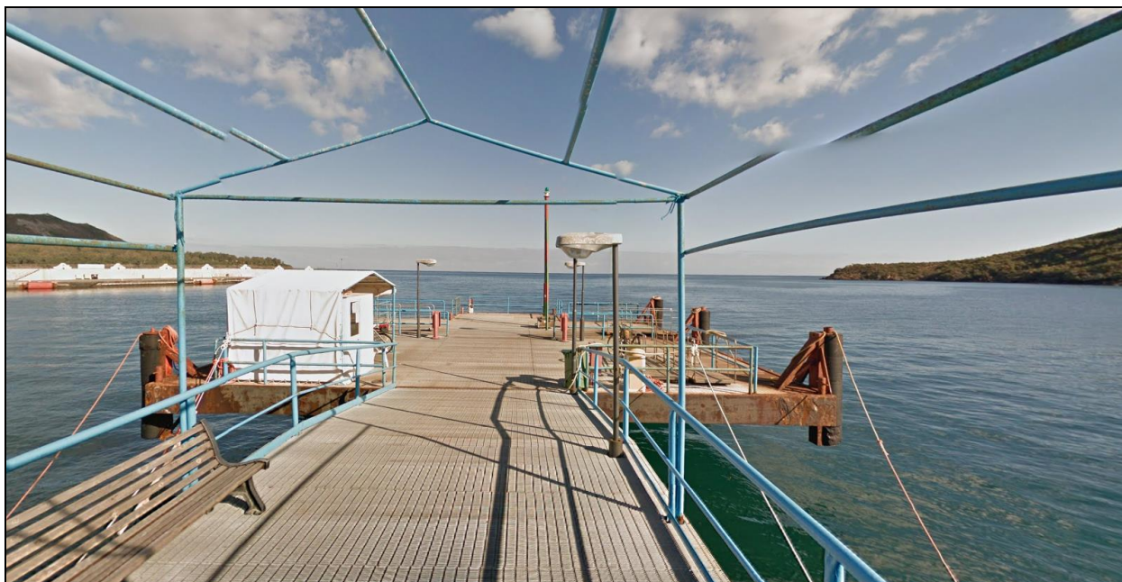
Figura 5-5 – Vista da terra del pontile allo stato attuale
