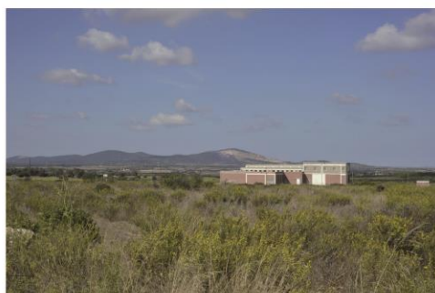
Vista di dettaglio - stato attuale
