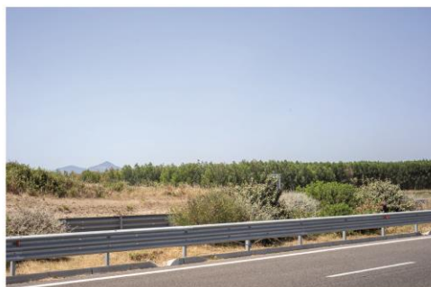
Vista di dettaglio - stato attuale
