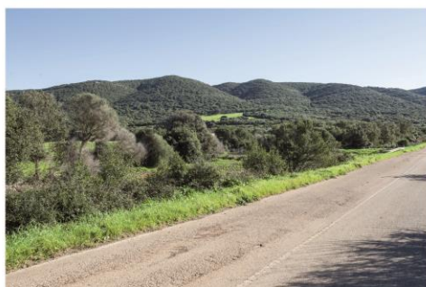
Vista di dettaglio - stato attuale
