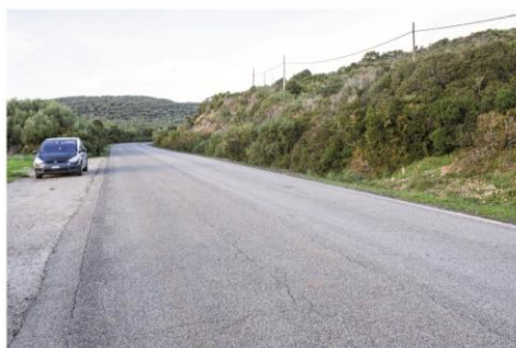
Vista di dettaglio - stato attuale
