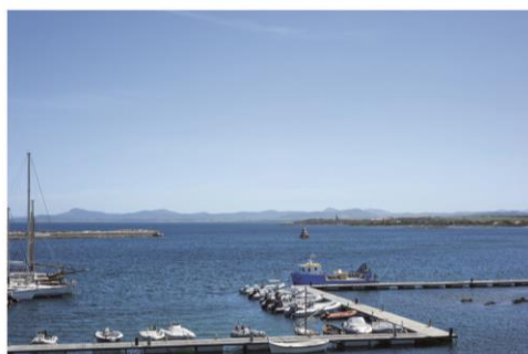
Vista di dettaglio - stato attuale
