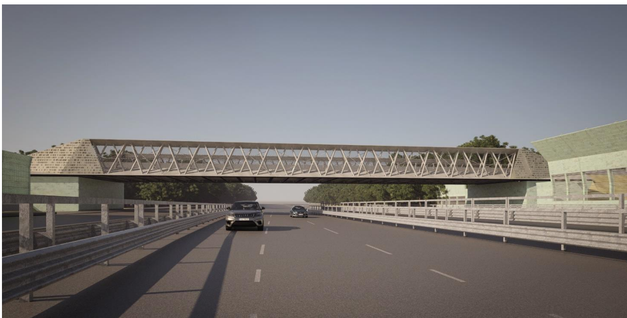
Nuovi cavalcavia - Vista del cavalcavia di Via Benazza
