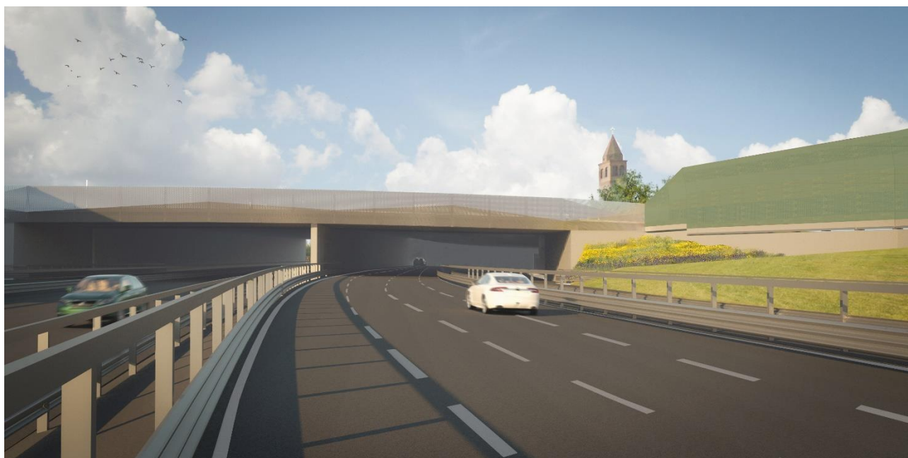
Nuovi cavalcavia - Vista del cavalcavia di Via San Donato
