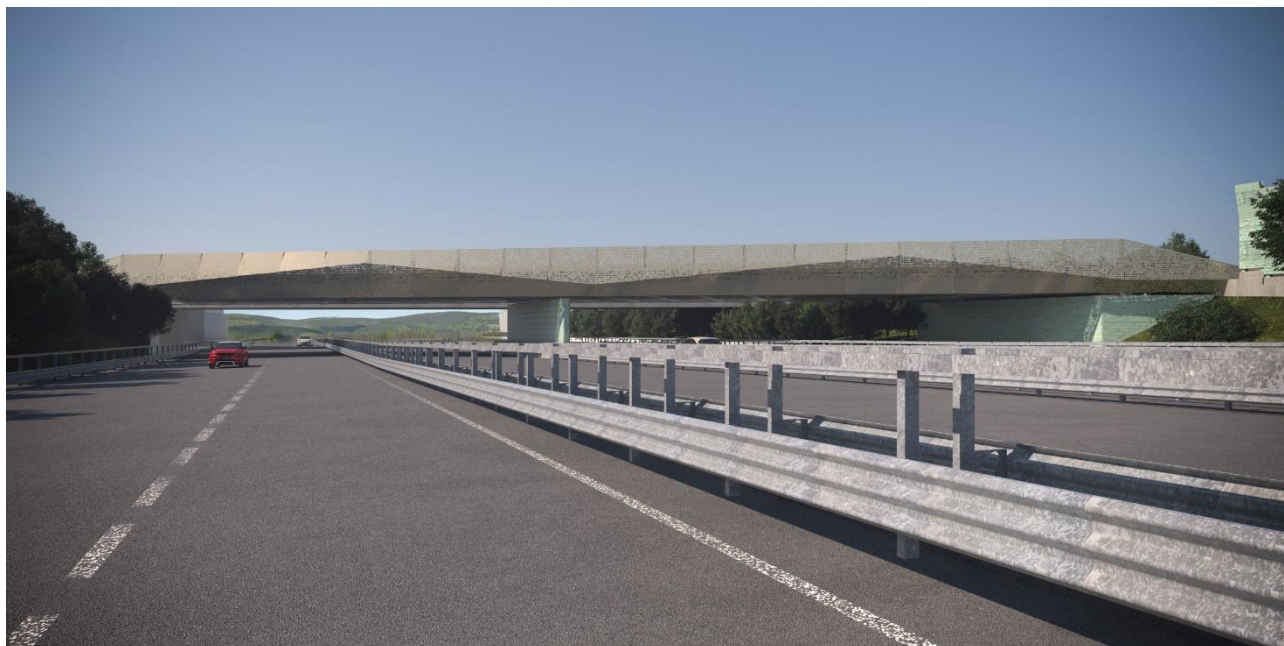
Nuovi cavalcavia - Vista del cavalcavia di Via Cristoforo Colombo
