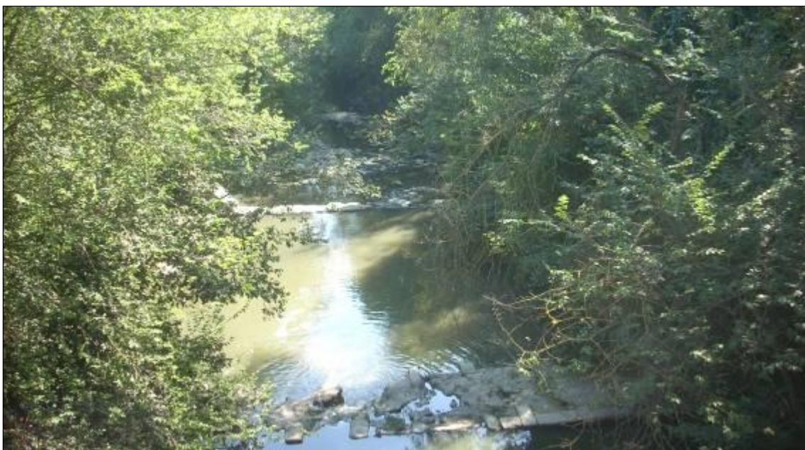
Fig.51 - Alveo del T. Savena: depositi alluvionali recenti, spessore medio di 1 m; si individua il profilo di due briglie fluviali dotate di scarsa manutenzione (località Caselle).
