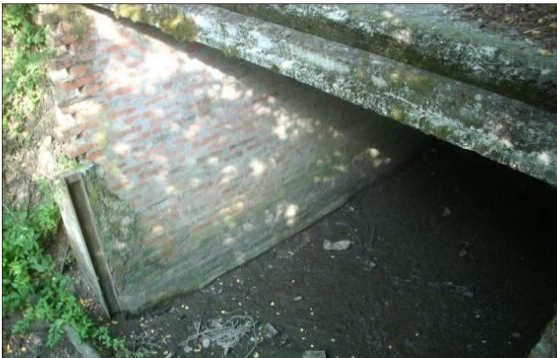
Fig.40 - Alveo Savena Abbandonato, si noti lo scatolare in muratura per l'attraversamento.
