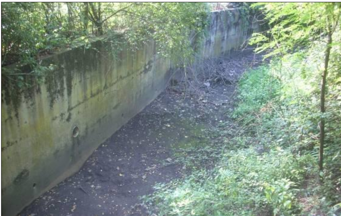
Fig. 39 - Alveo attuale del Savena Abbandonato, si noti la risagomatura artificiale delle sponde.
