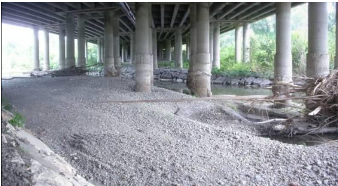
Fig.29 - Alveo del F. Reno: depositi alluvionali recenti (foto 2016); sono presenti scogliere artificiali
