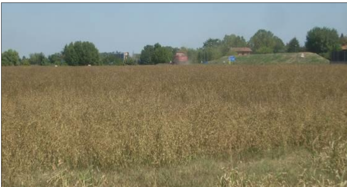
Fig.53 – Rilevato artificiale in località Case Alte, con altezza variabile da 3-5 m con funzione di mitigazione acustica.
