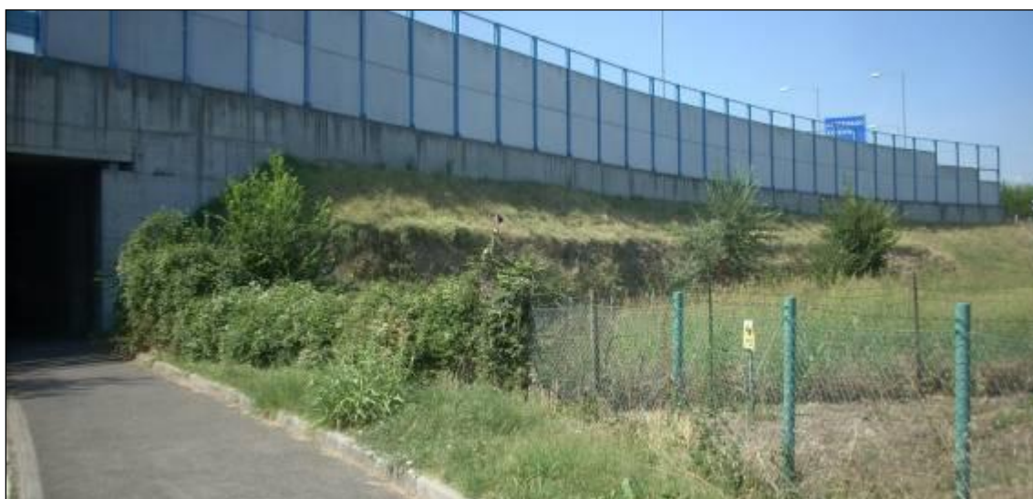
Fig.55 – Rilevato artificiale con altezza media di 3-4 m circa relativo al muro di contenimento con funzione portante del sistema tangenziale in esercizio (località Croce del Biacco).
