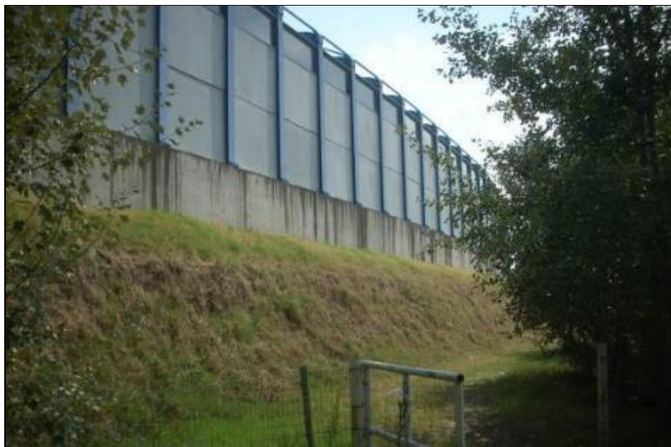
Fig.45 – Rilevato artificiale, in via del Saliceto con altezza media da 2÷3 m circa con funzione portante del muro di contenimento del sistema tangenziale in esercizio.
