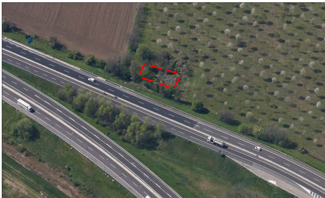
Immagini aeree oblique - Vista Ovest (fonte Sit bologna)
