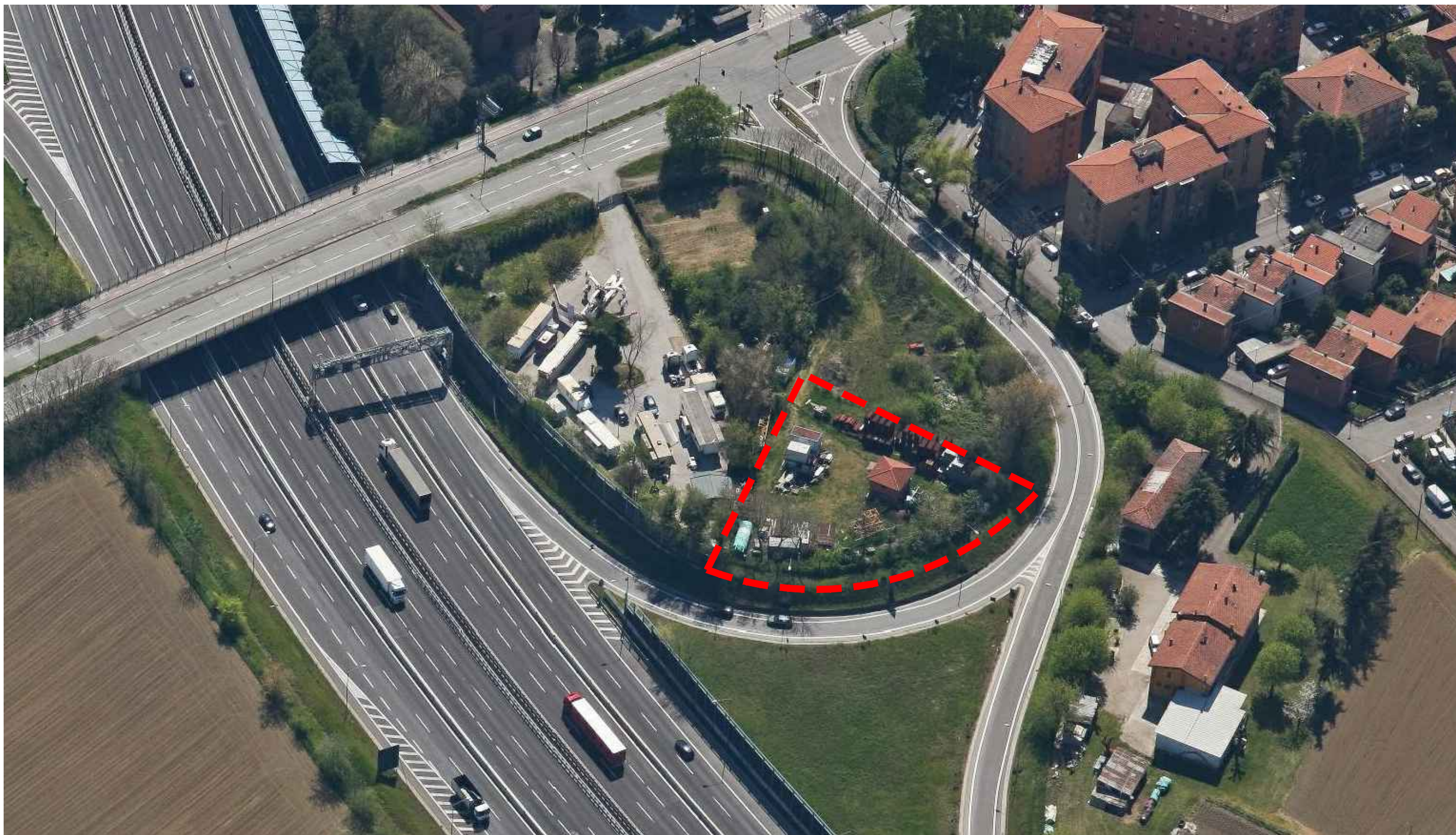
Vista aerea Edificio Via San Donato
