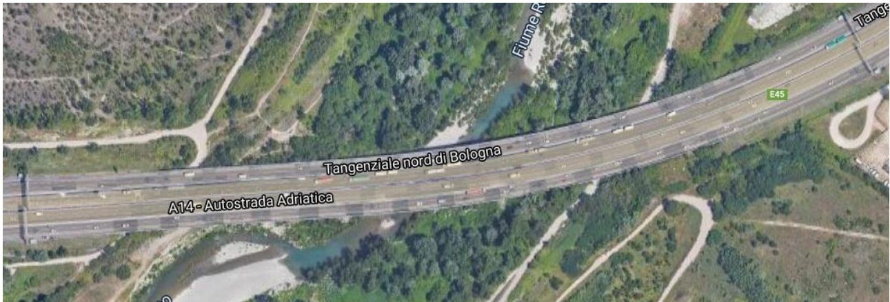
Viadotto Reno A14 Km 9+925
