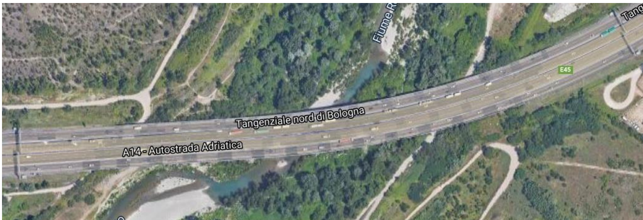
Viadotto Reno A14 Km 9+925
