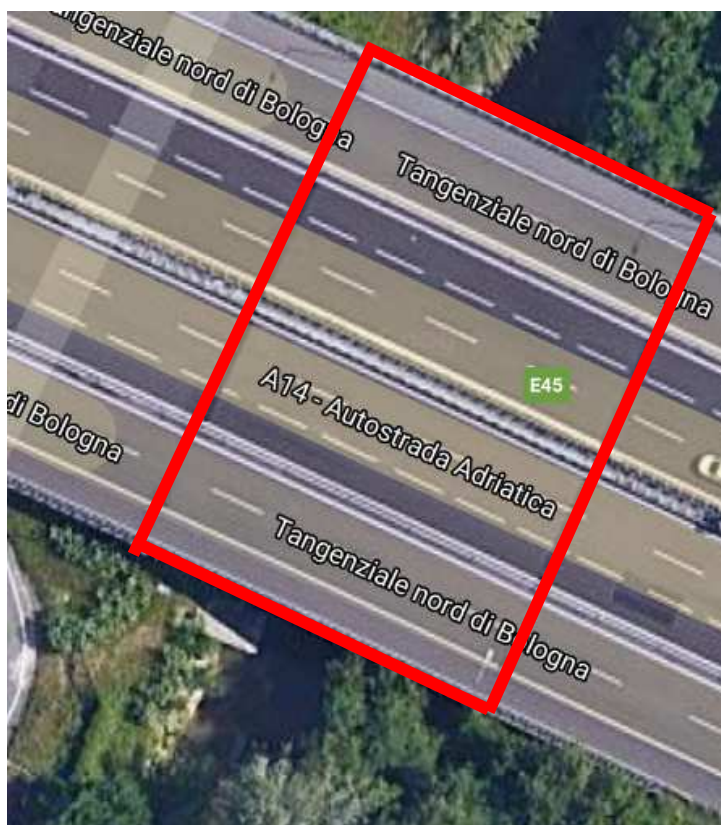
Viadotto Savena A14 Km 21+ 312
