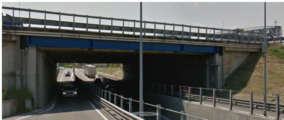
Figura 1-4. Localizzazione geografica dell'opera (4) – Vista Carreggiata Nord
