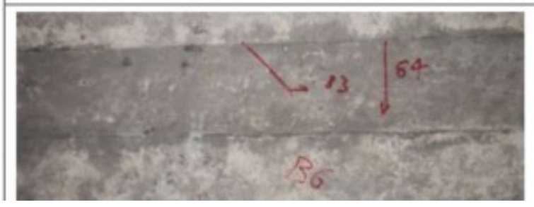
Figura 1-23 – Indagini 2020 su strutture esistenti – Rilievi geometrici e pacometrici
