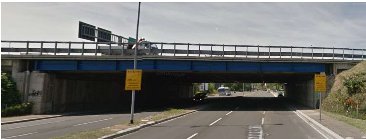
Figura 1-4. Localizzazione geografica dell'opera (4) – Vista Carreggiata Nord
