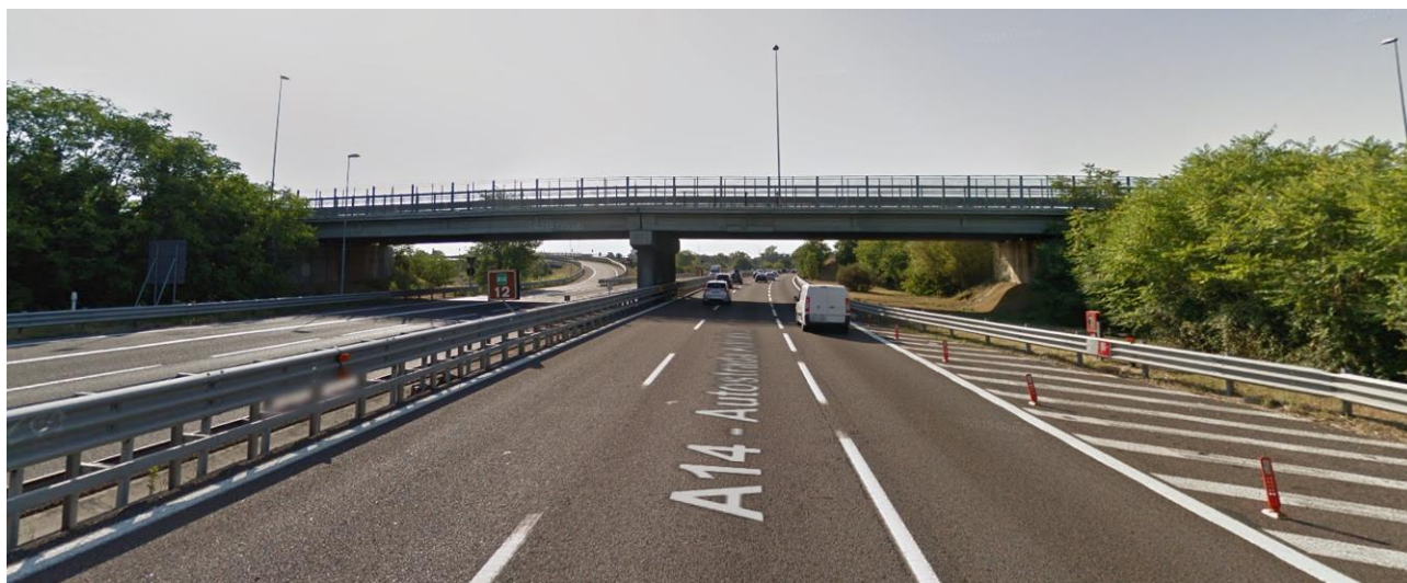
Figura 1-3 – Localizzazione geografica dell'opera (3) – Vista Carreggiata direzione Sud
