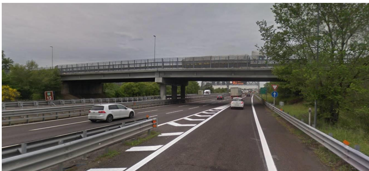
Figura 1-4 – Localizzazione geografica dell'opera (4) – Vista Carreggiata direzione Nord
