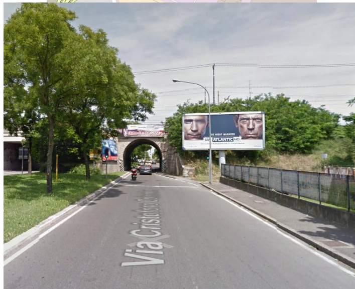
Figura 1-2: Via Cristoforo Colombo – carreggiata direzione Nord – Attraversamento ferroviario (cartografia Open Street Map).
