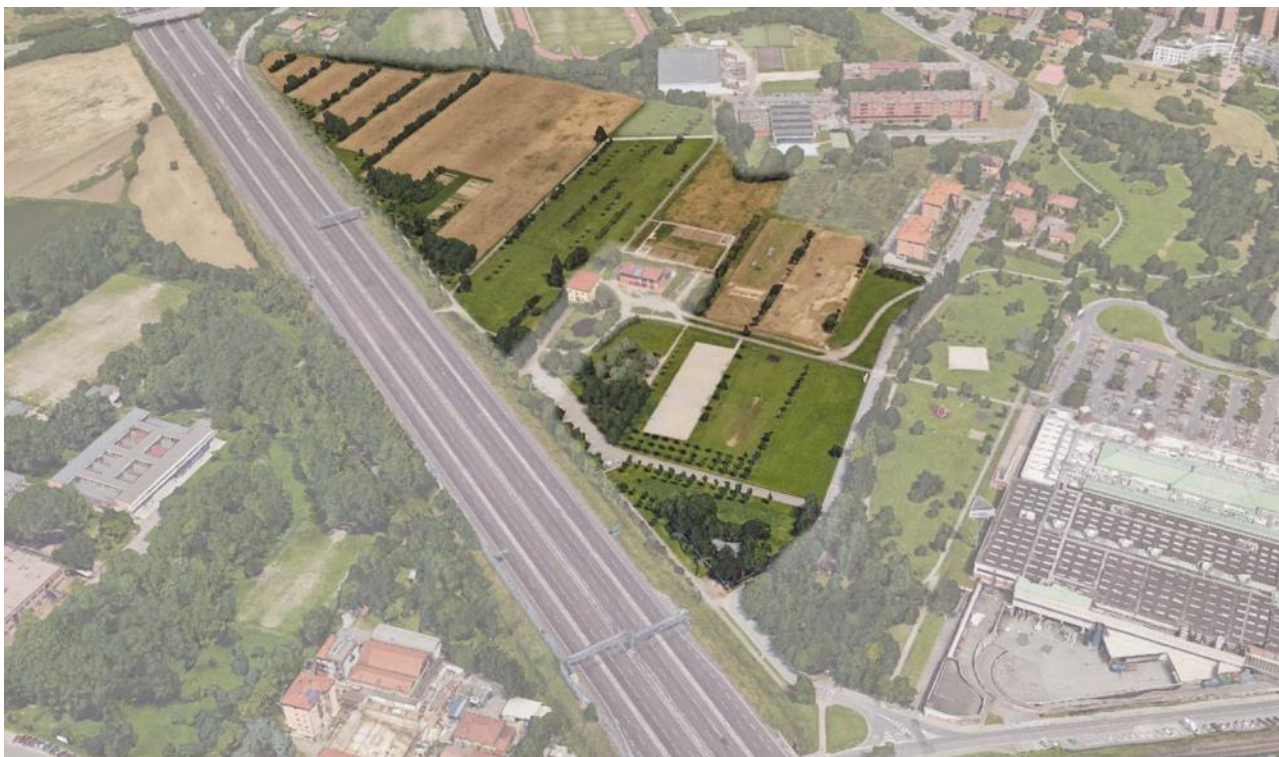
Figura 7-24. Campagna via Larga - stato di fatto. Fonte: Google Earth
