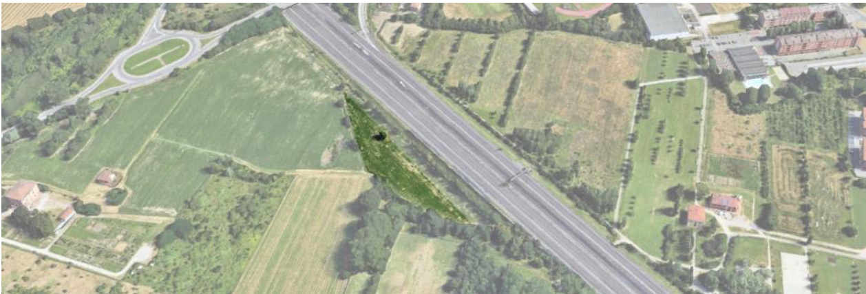
Figura 7-23. Fascia Boscata Scandellara - stato di fatto. Fonte: Google Earth, rielaborato.
