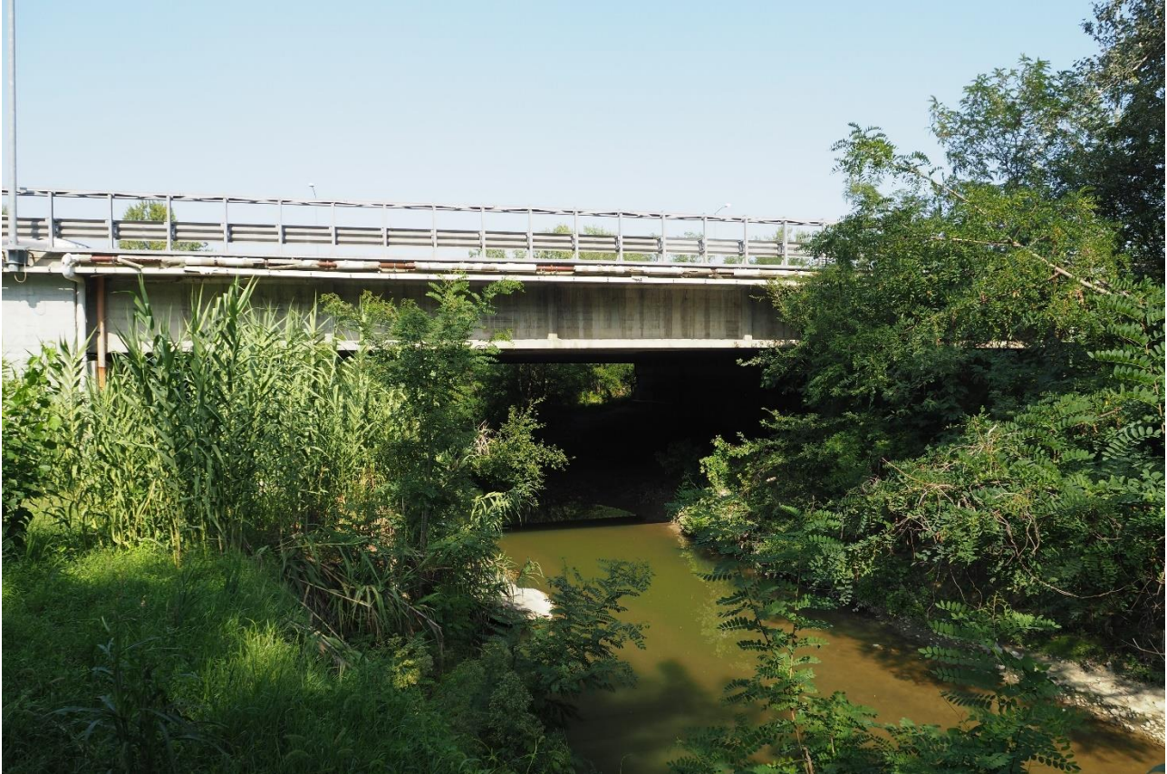
Figura 3-2: Savena a valle dell'autostrada
