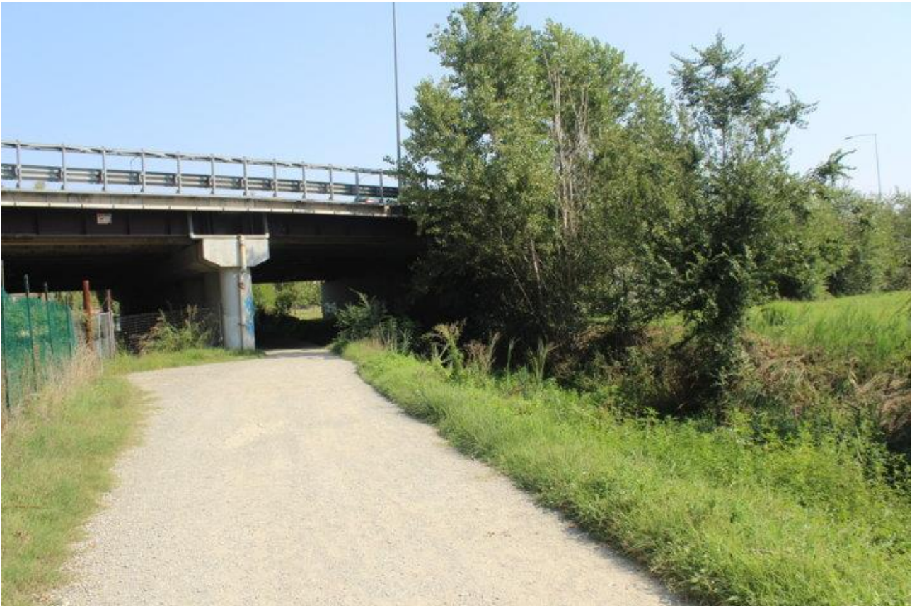
Figura 3-3: alveo del canale Navile a valle della sede autostradale
