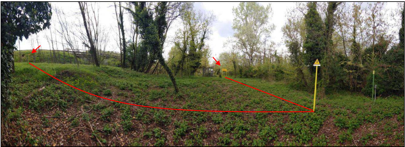
Figura 18 - Riprese fotografiche dell'area di intervento e scavo B': sopra, vista verso est; sotto, vista verso ovest: la traccia, indicativa, del metanodotto interrato è curva per compensare la distorsione della fotografia panoramica a 360
