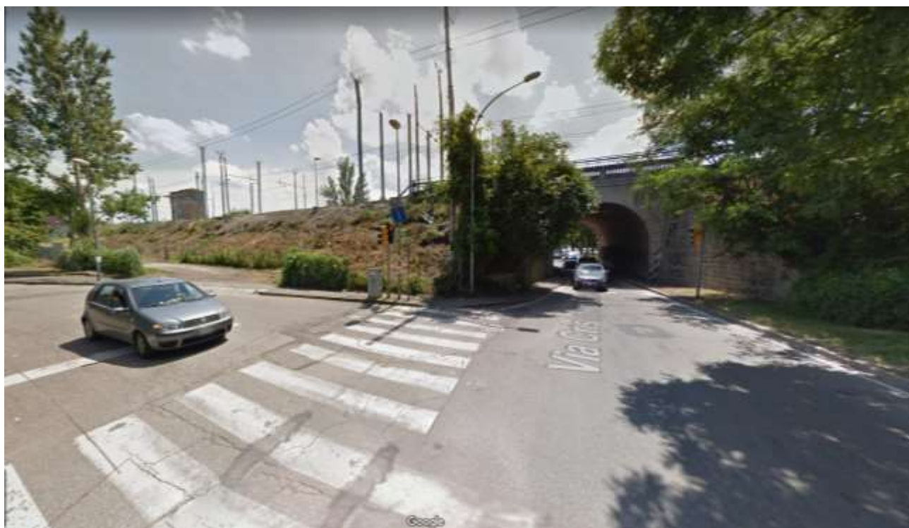
Figura 8 – Vista attraversamento linea FF.SS. BO-PD vista sud
