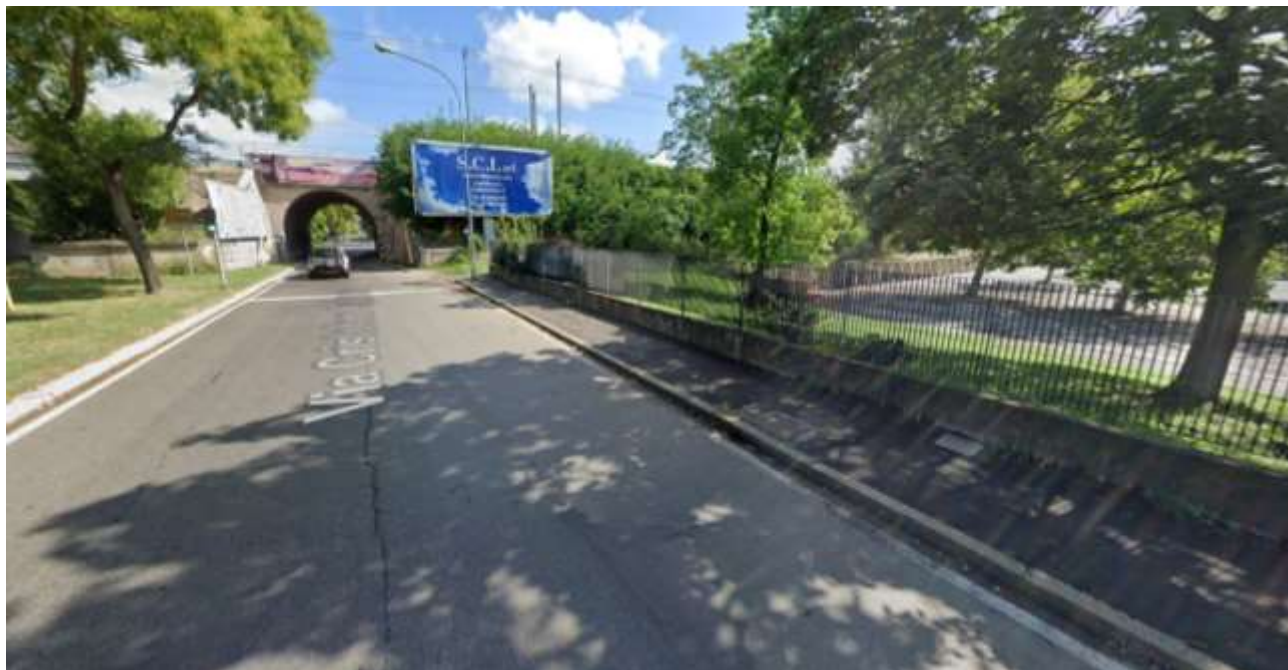
Figura 7 – Vista attraversamento linea FF.SS. BO-PD vista nord
