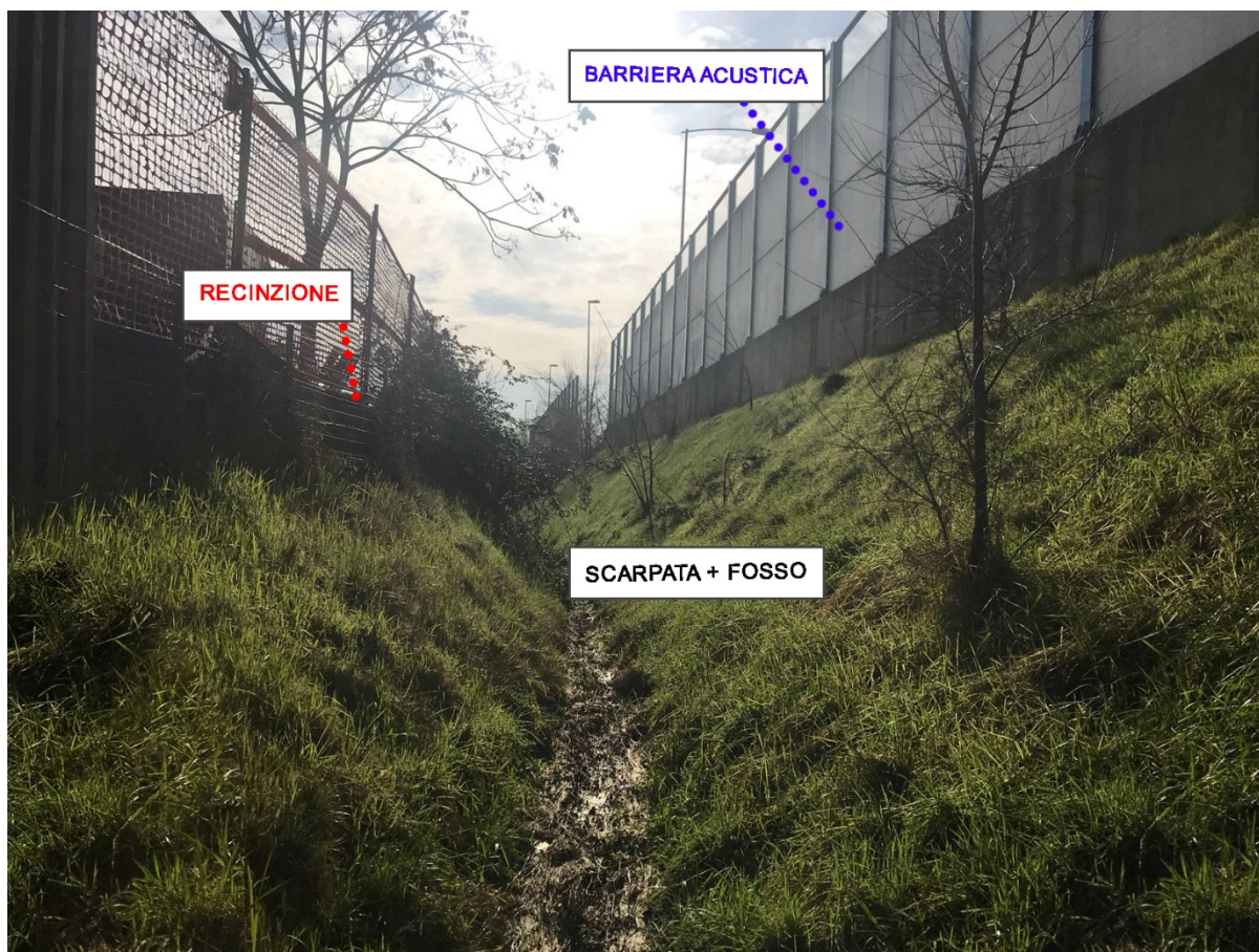
Fotografia dello Stato di Fatto dell'area esterna a confine con l'autostrada (scarpata+fosso+recinzione)
