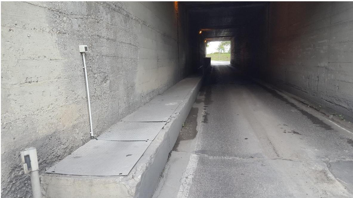
**Figura 5 Interno sottopasso con manufatto per passaggio linee elettriche di illuminazione e alimentazione Pompe sollevamento percolato discarica EX GUELFA**
