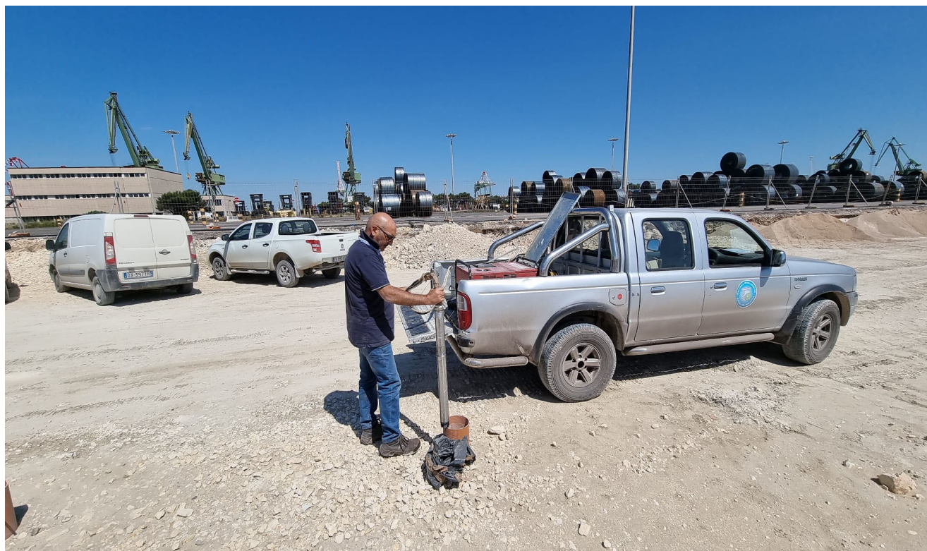
Fig. 1) Installazione strumentazione di prova nell’area di indagine
