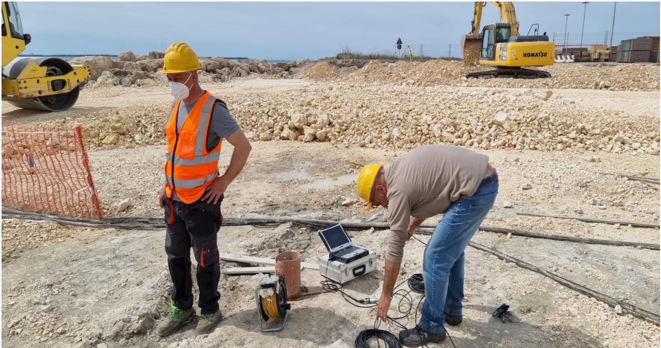
Fig. 2) Lettura recovery con trasduttore di pressione nell'area di indagine
