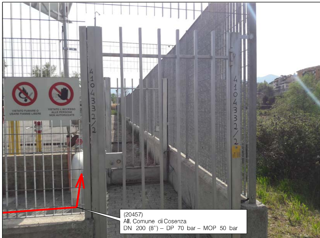
Vista PIDA n. 4104332/2 in esercizio da rimuovere nel territorio di Castrolibero
