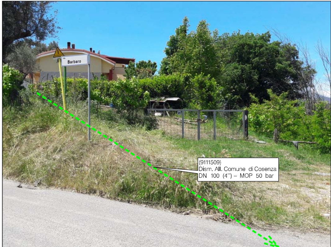
Vista c.s.g. Attraversamento via Barbaro nel Comune di Castrolibero
