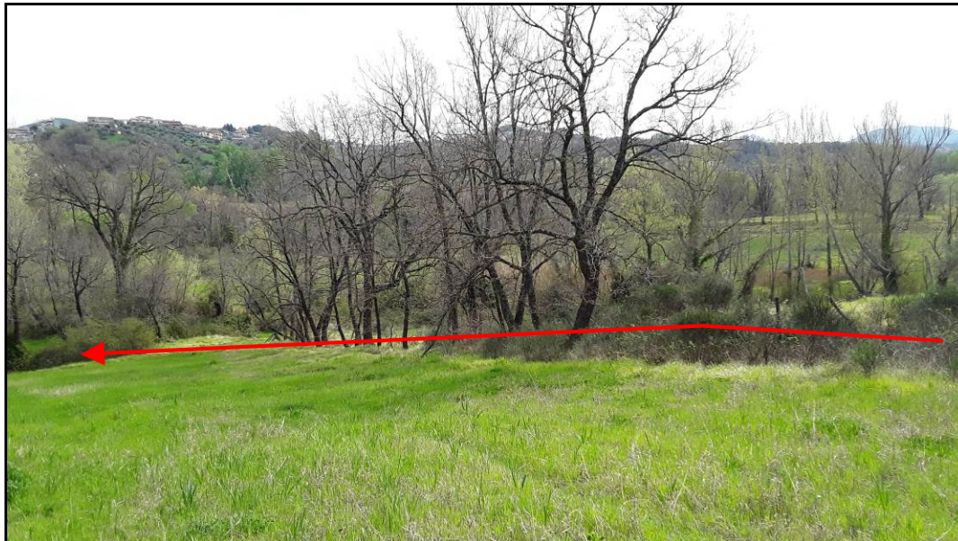
Foto 2.4.2/D – Foto 1 – Inizio tracciato, attraversamento filari su versante – (tracciato di progetto in rosso)
