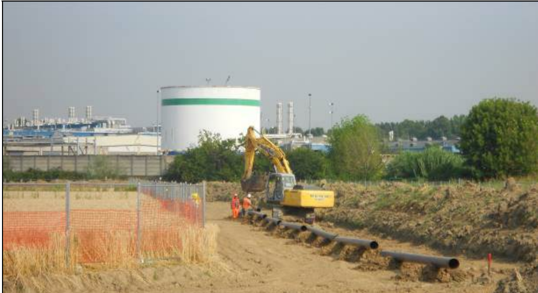
Fig. 9.3/A: Sfilamento tubi
