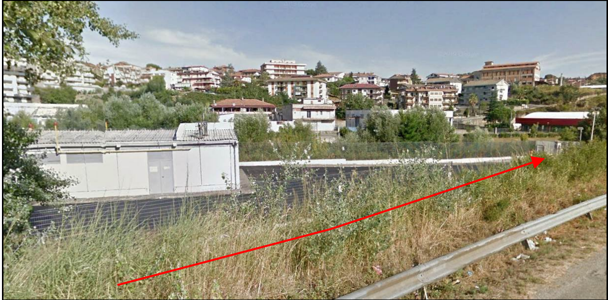
Foto 2.4.2/D – Foto 9 – Percorrenza area impiantistica ed arrivo, Piana alluvionale destra (tracciato di progetto in rosso)
