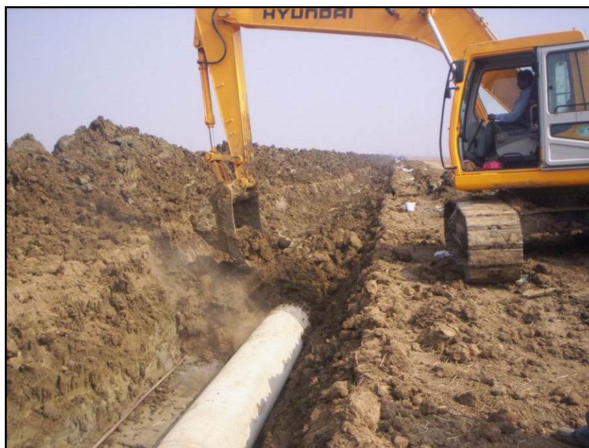
Fig. 9.9/A: Rinterro della condotta
