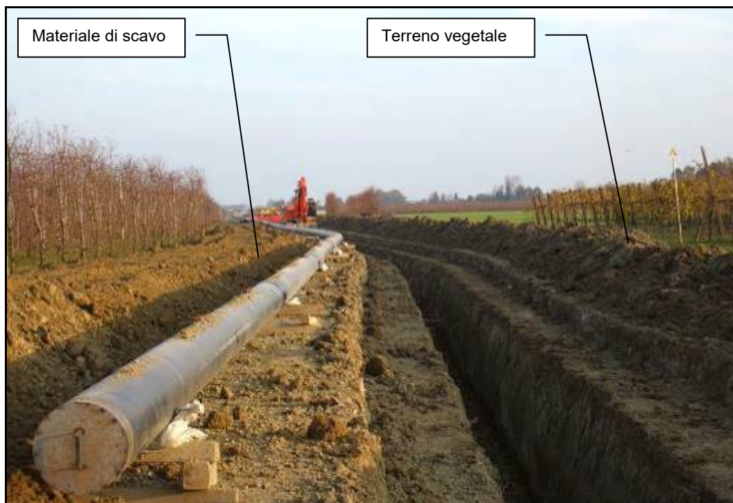
Fig. 9.6/A: Scavo della trincea
