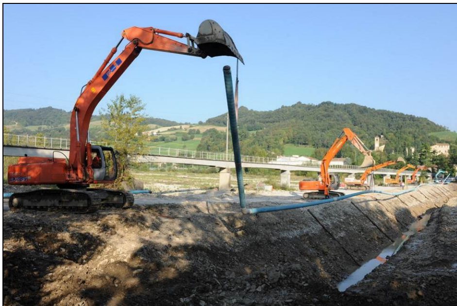
Fig. 9.8/A: Posa della condotta
