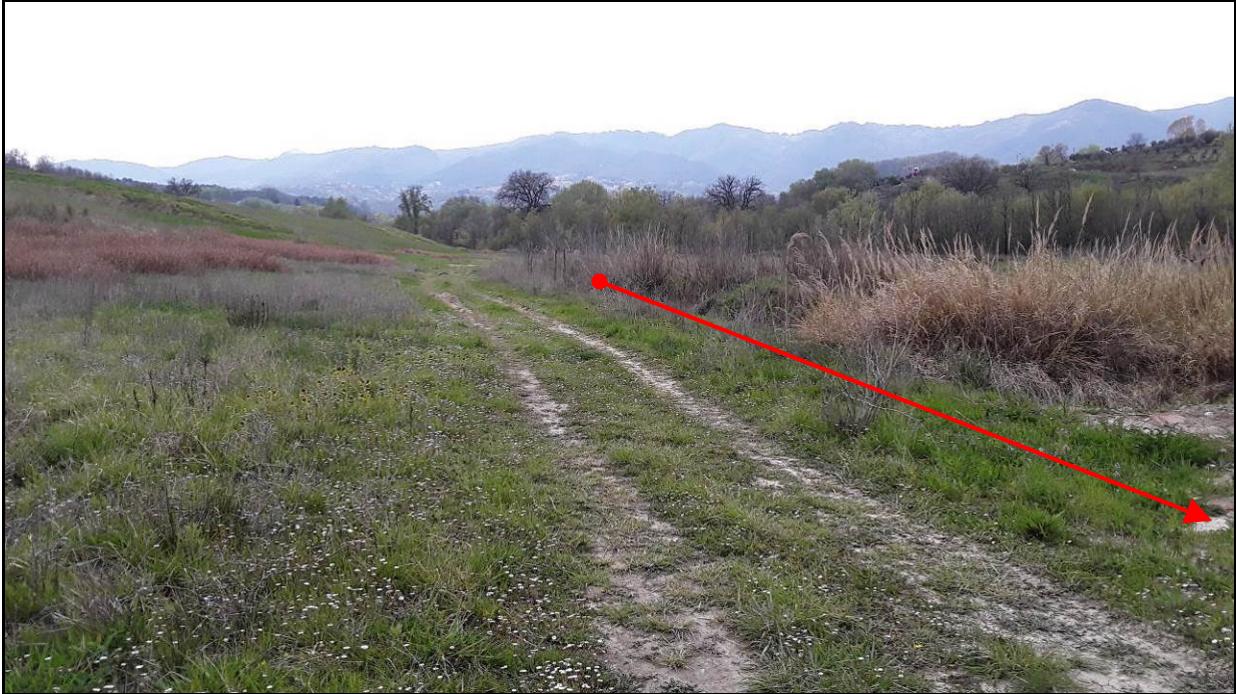
Foto 2.4.2/D – Foto 3 – Fine 1° TOC, terrazzo alluvionale destra idrografica – (tracciato di progetto in rosso)
