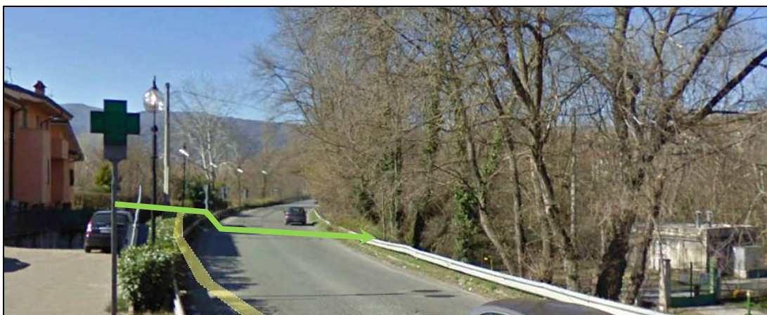
Foto 2.4.2/E – Foto 2 – Tracciato in dismissione (in verde)
