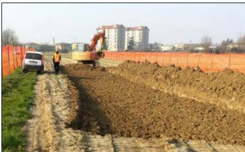
Fig. 9.2/A: Apertura della pista di lavoro
