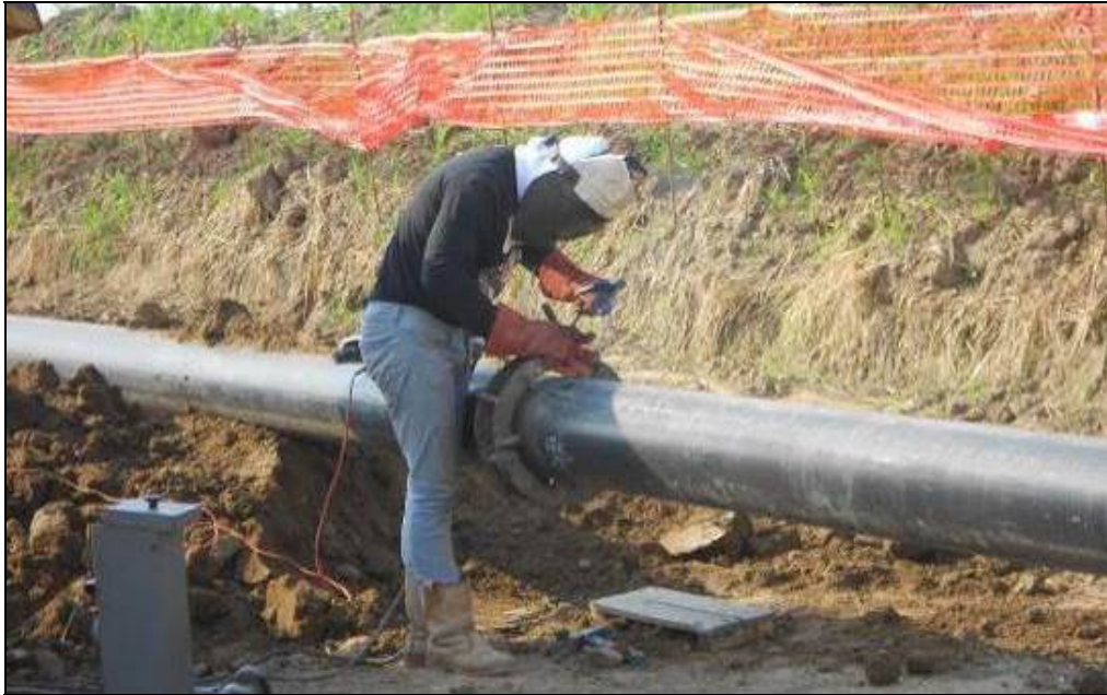
Fig. 9.4/A: Saldatura della tubazione
