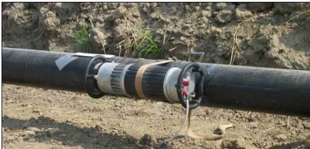
Fig. 9.5/A: Controlli non distruttivi delle saldature
