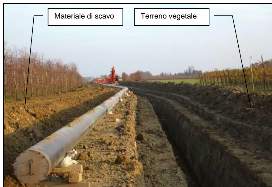
Fig. 8/E: Scavo della trincea
