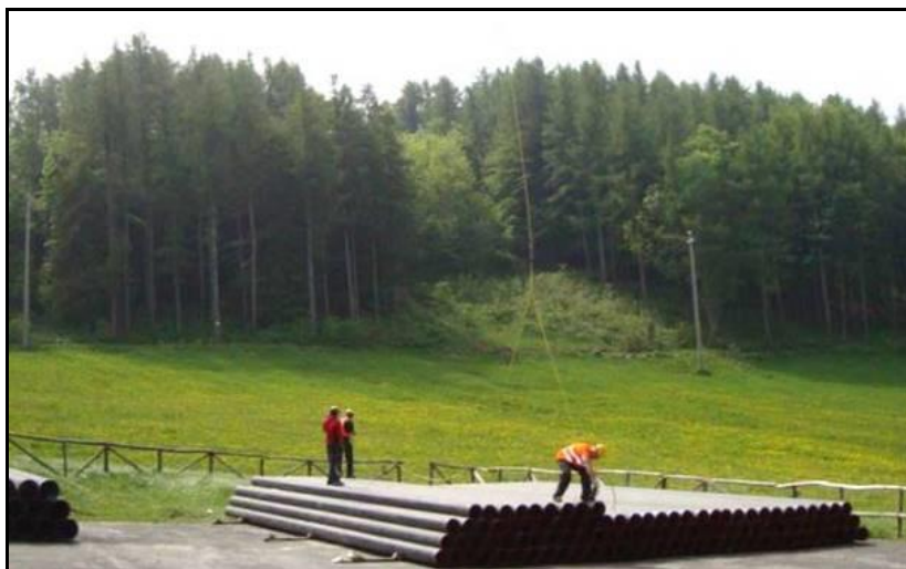
Fig. 8/A: Piazzola di accatastamento tubazioni
