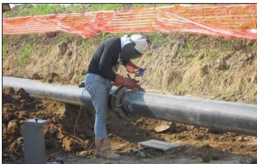
Fig. 8/D: Saldatura della tubazione
