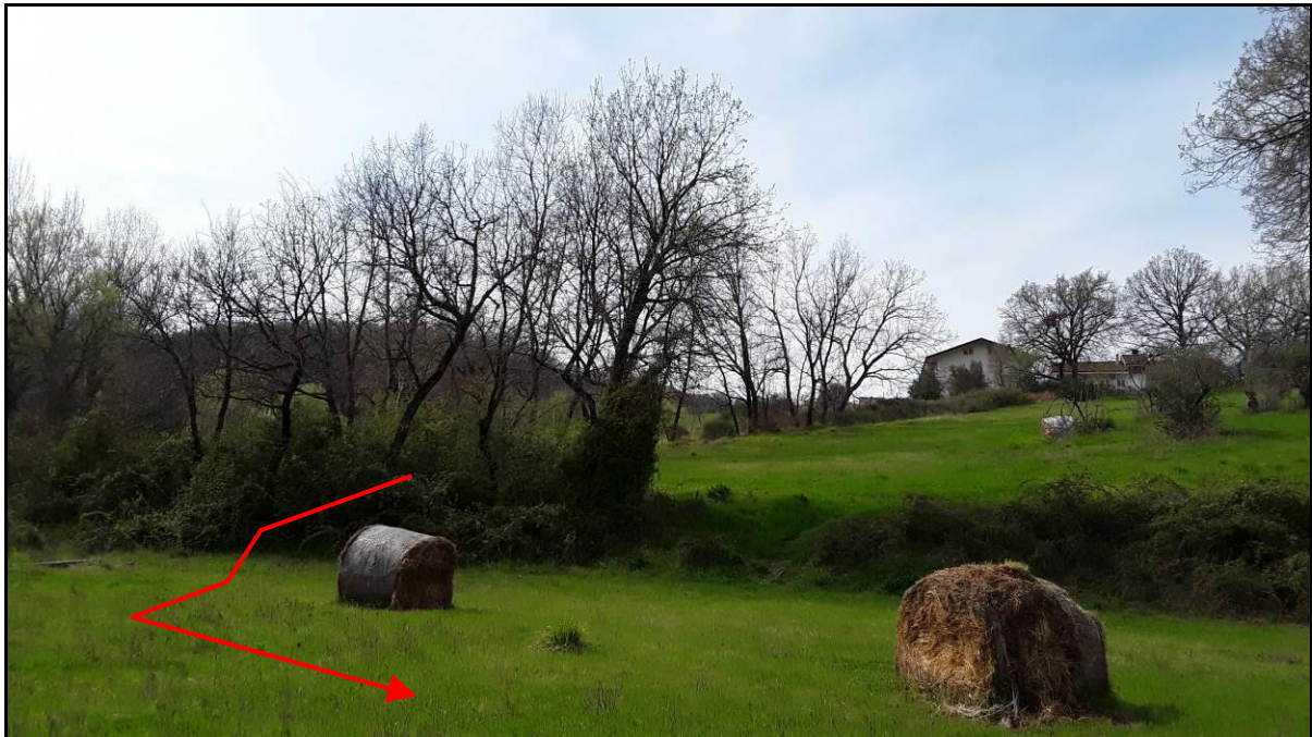
Foto 11.5/D – Foto 2 – Piana alluvionale sinistra, Inizio 1° TOC – (tracciato di progetto in rosso)
