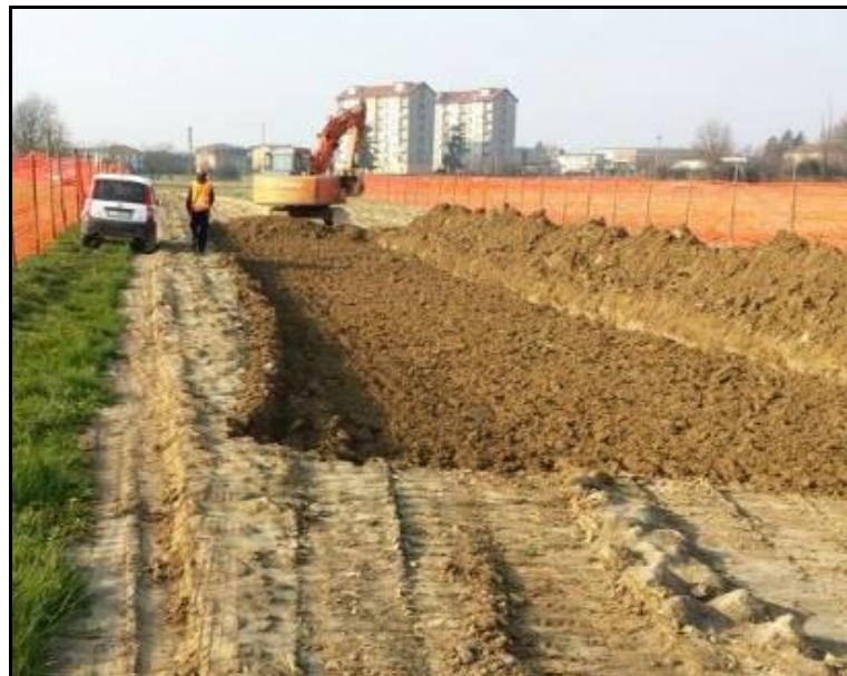
Fig. 8/B: Apertura della pista di lavoro
