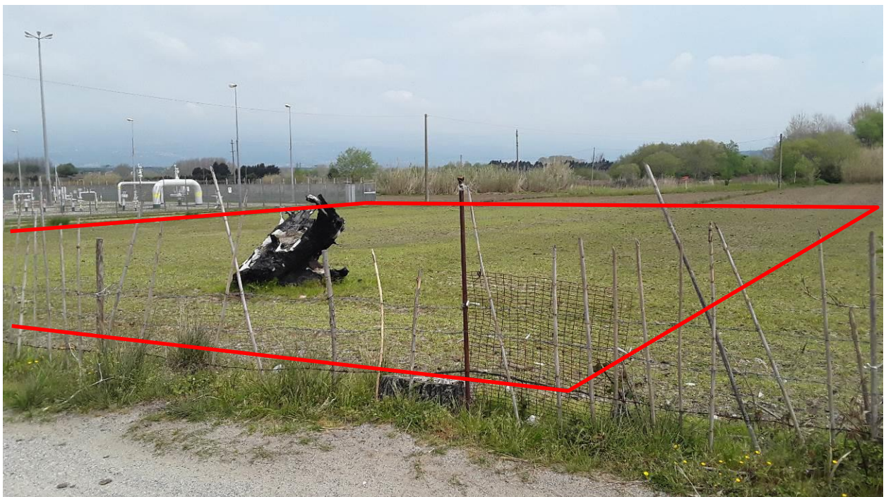
Foto. 11.5/B – Foto 2 – Localizzazione impianto (in rosso) e Impianto di Regolazione di Palazzo
