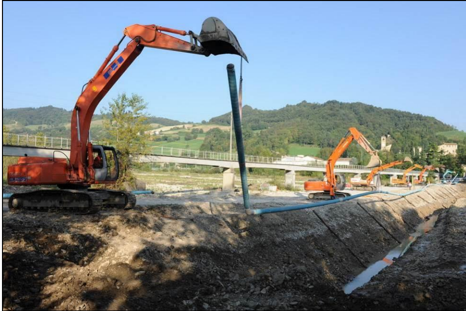
Fig. 8/F: Posa della condotta
