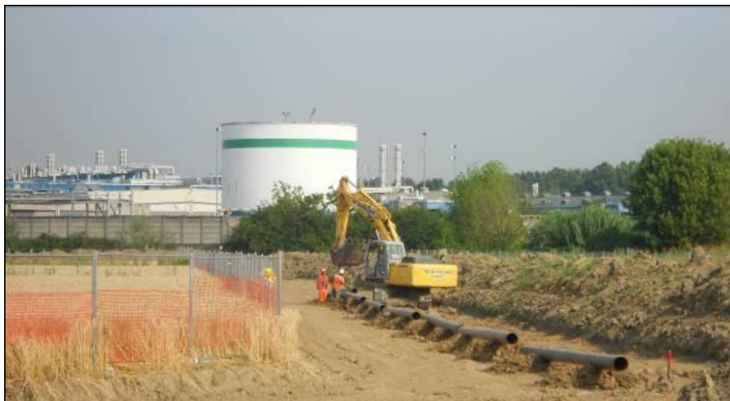
Fig. 8/C: Sfilamento tubi
