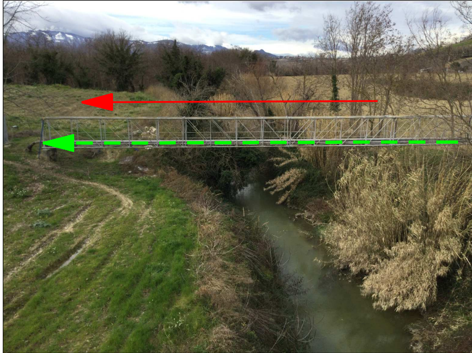
Attraversamento torrente Cigno
