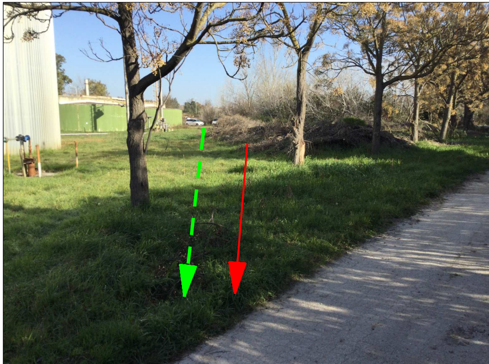
Percorrenza in prossimita' depuratore
