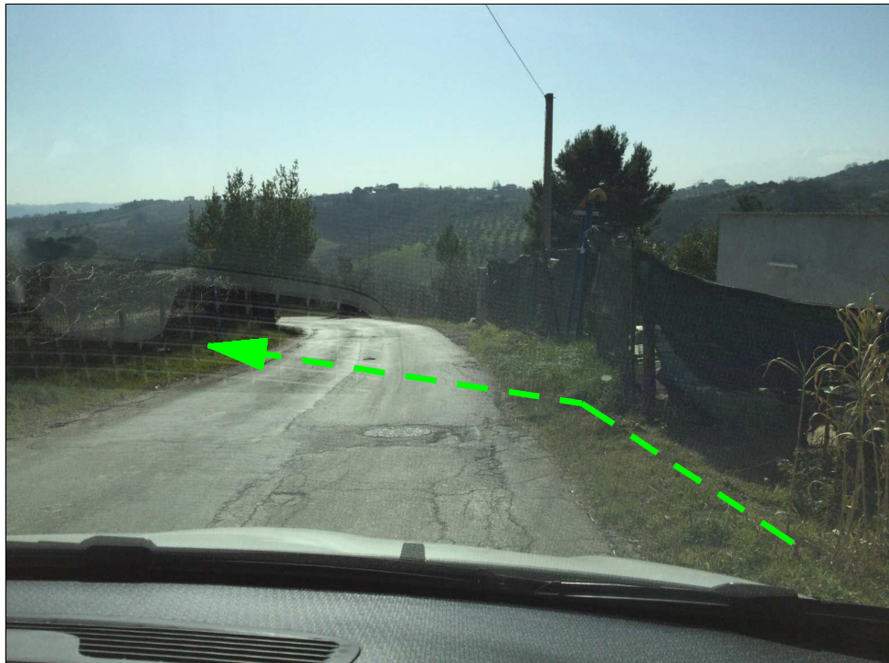
Attraversamento strada Da Denominare n.32
