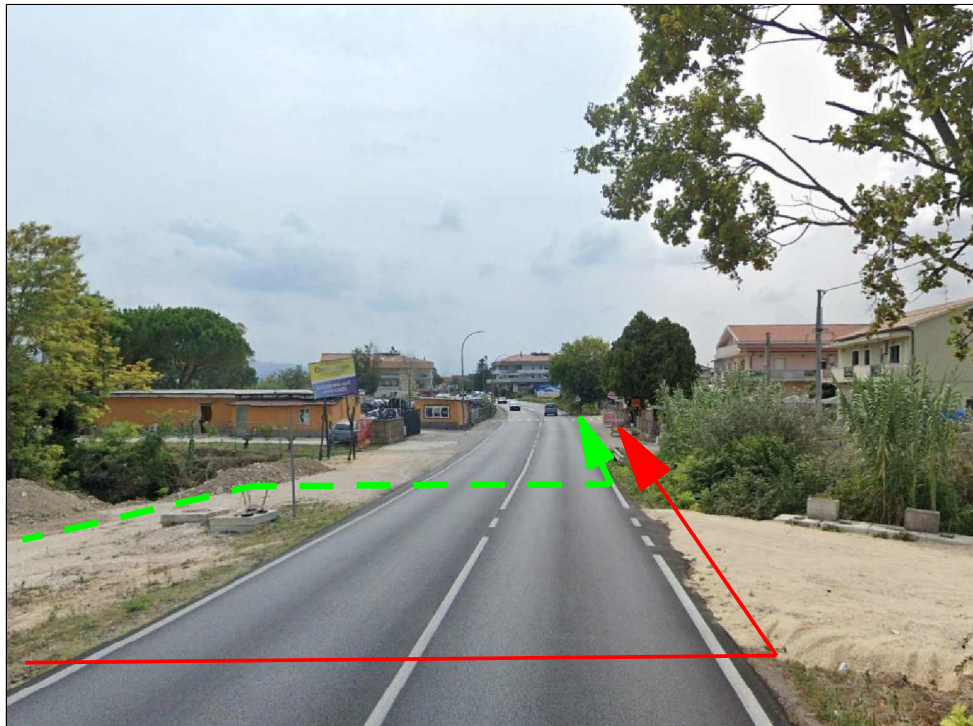
Attraversamento S.R. n.602
