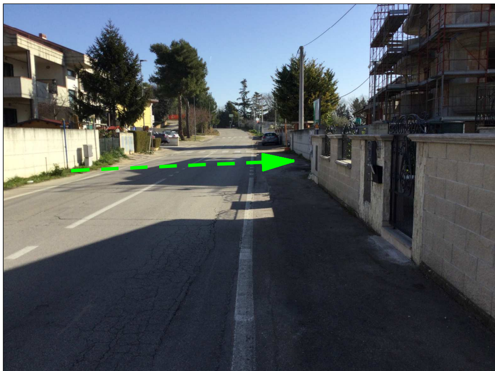
Attraversamento S.P. n.25
