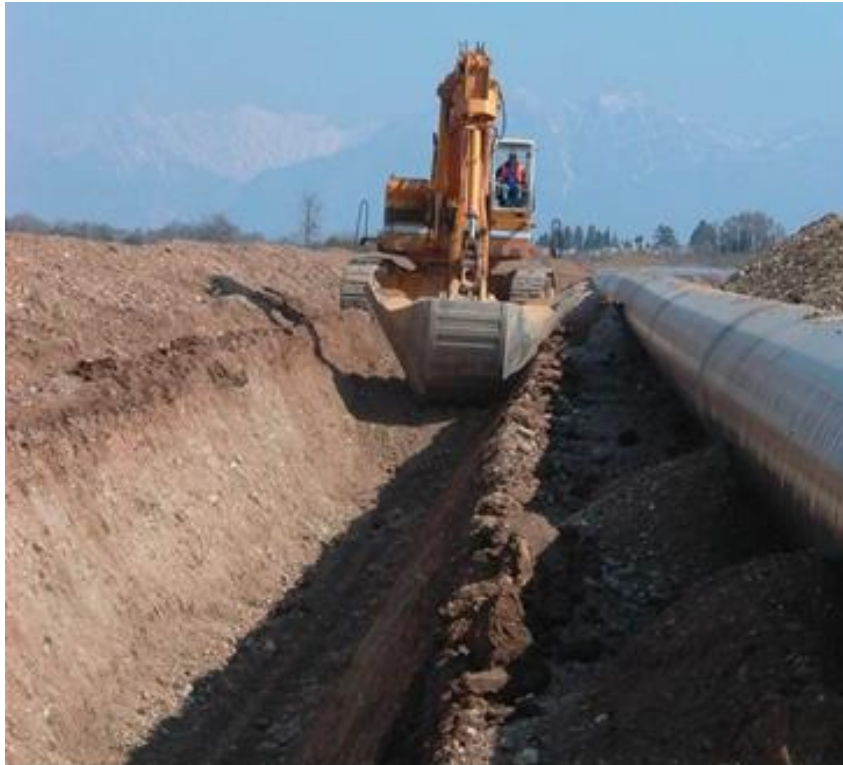
Fig. 7.3 - Scavo per l'alloggiamento della condotta
