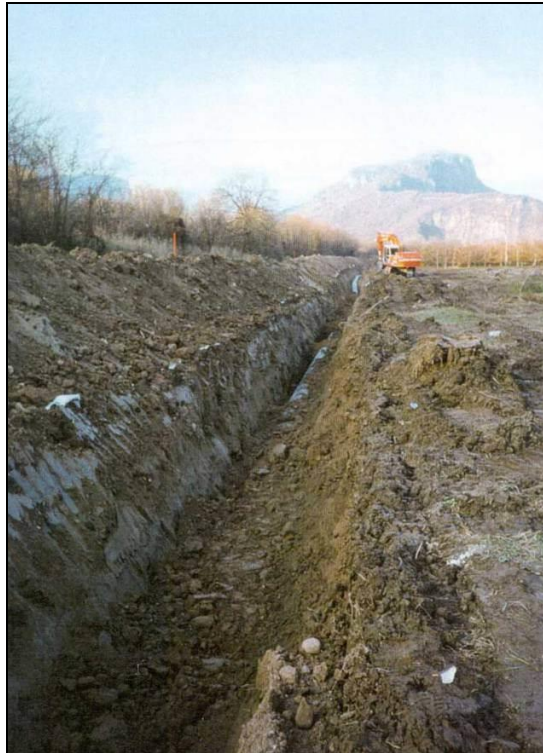
Fig. 7.5 - Operazione di rinterro della condotta
