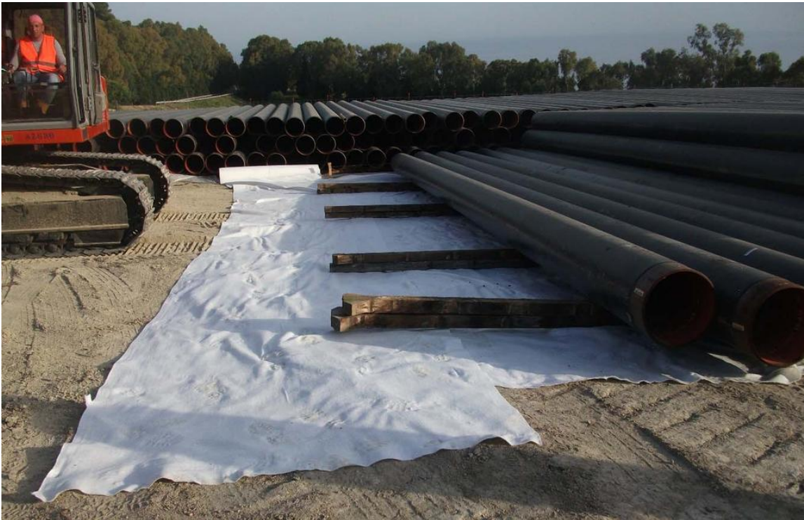
Fig. 7.1 - Piazzola di accatastamento tubazioni
