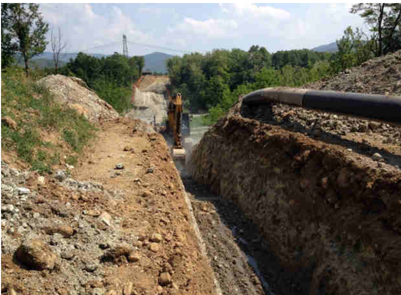
Fig. 2.2 - Scavo per l'alloggiamento della condotta.
