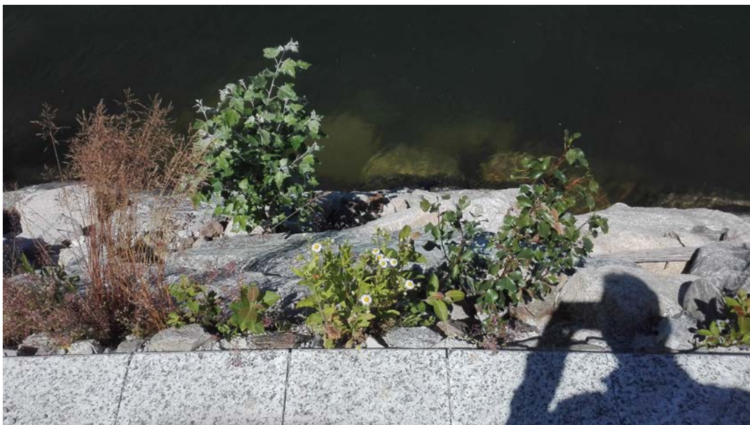
Figura 8: Dettaglio della scogliera in fase di colonizzazione di vegetazione igrofila
