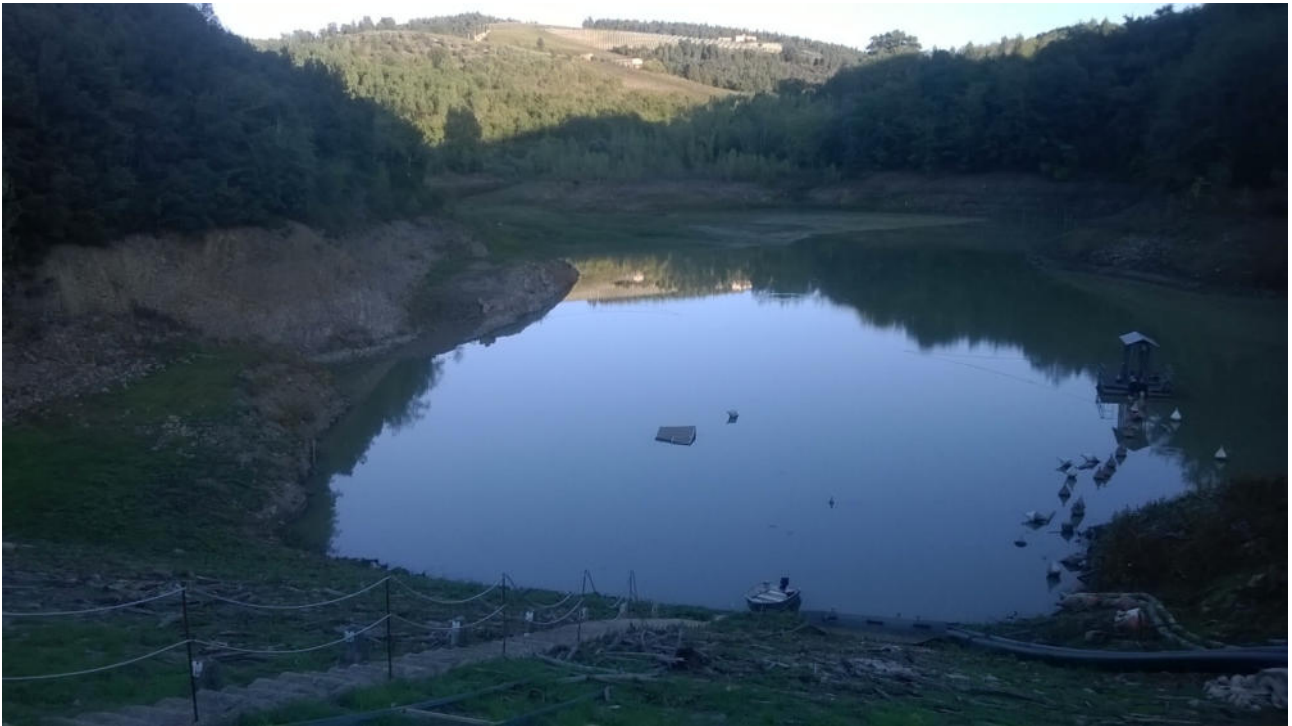
Figura 4 – Area dell’invaso vista dal paramento.
