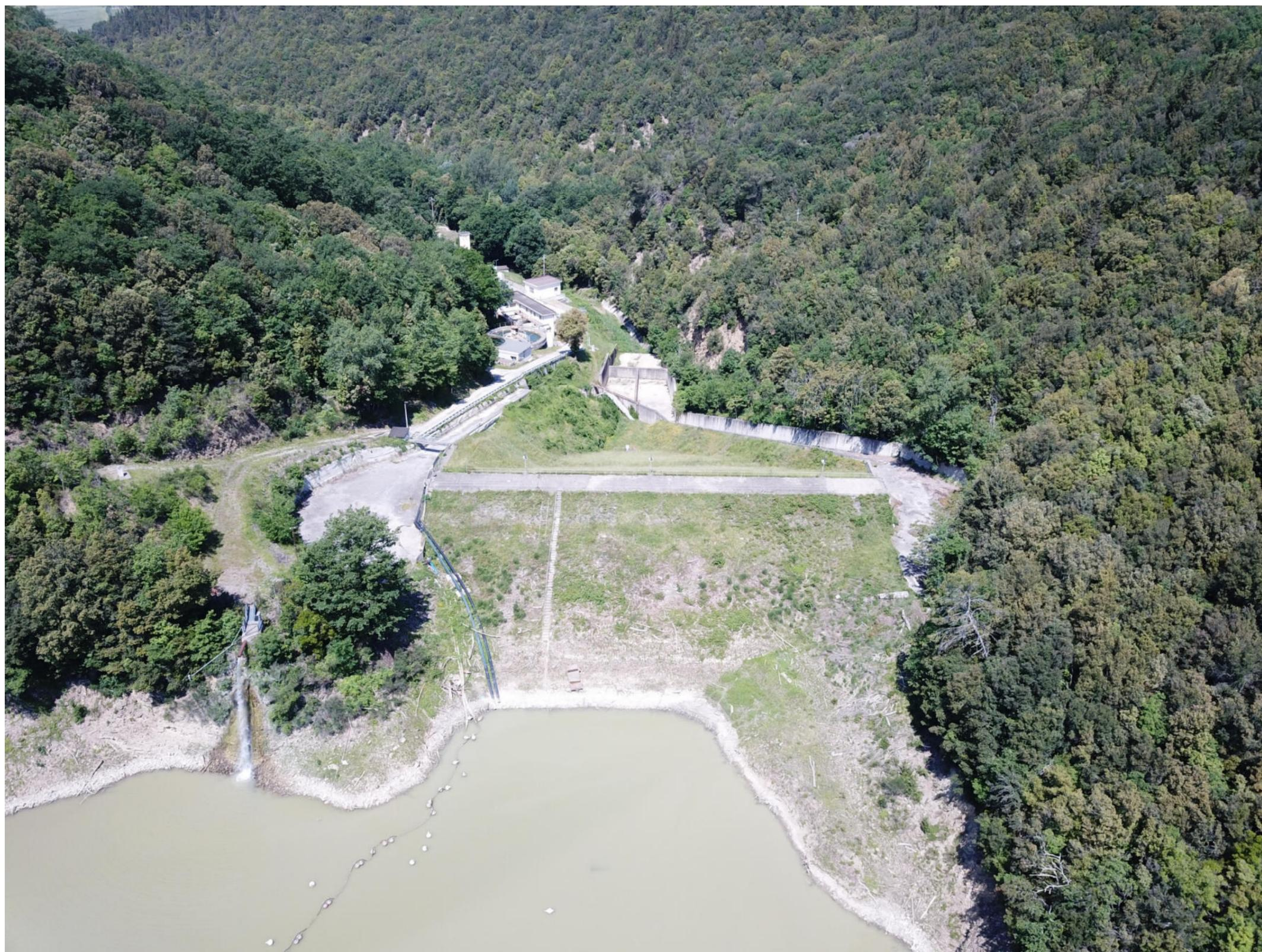
Figura 3 Stato attuale ripresa dal drone al centro del lago attuale. Sono ben visibili il coronamento e due sfioratori attuali, come la vasca di dissipazione e l'impianto di potabilizzazione sulla sinistra a valle della diga.
