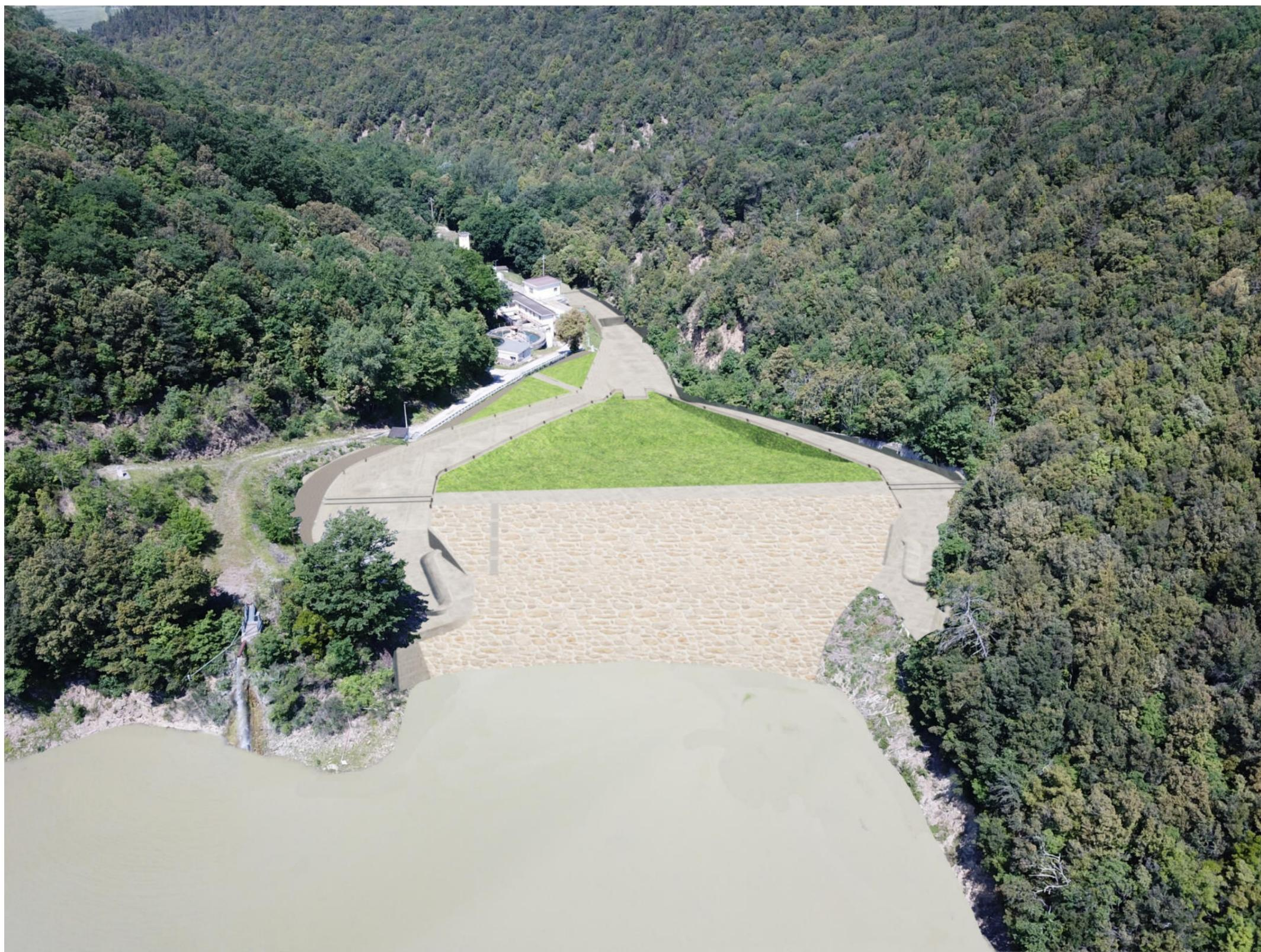
Figura 4 Stato attuale ripresa dal drone al centro del lago attuale. Sono ben visibili si può notare come l'intervento renda più efficiente da un punto di vista idraulico l'opera e il suo impatto maggiore rispetto all'esistente sia in corrispondenza della vasca di dissipazione che comunque si sviluppa all'interno delle aree di pertinenza dell'impianto di potabilizzazione.
