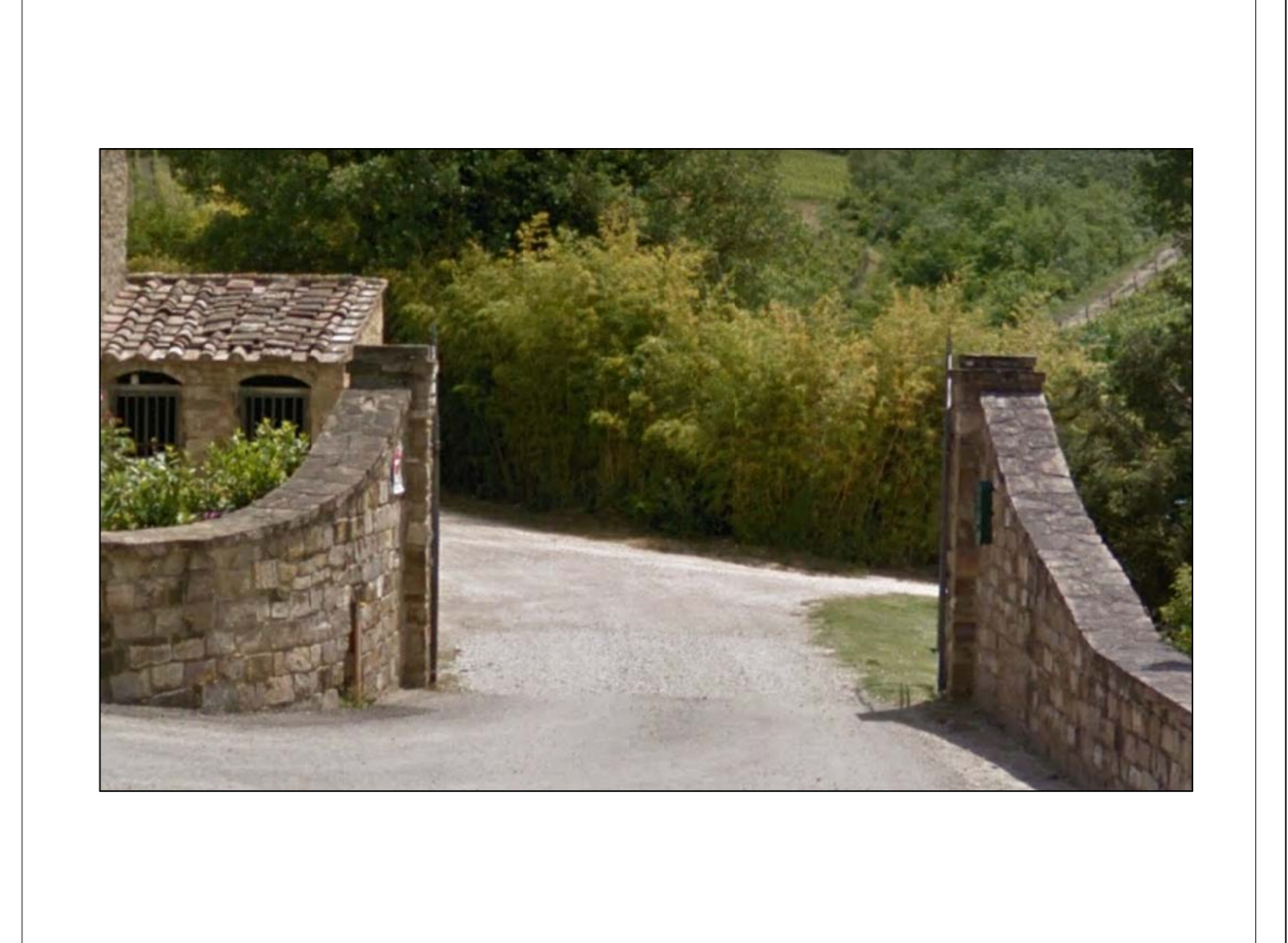
ACCESSO AL CANTIERE SU VIA MONSANTO
