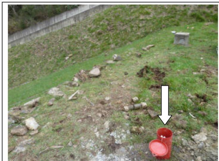
Pozzetto piezometri di S6-16
