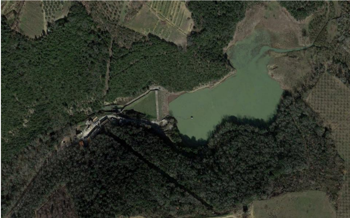
Figura 2-2 - Diga Drove di Cepparello. Fonte Google Maps
