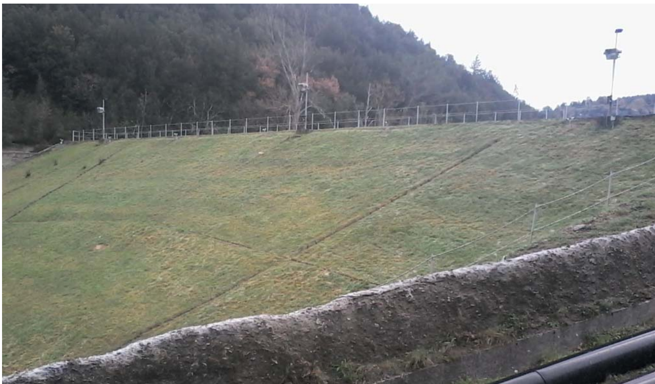
Figura 2-4 – Impianto di illuminazione sul coronamento
