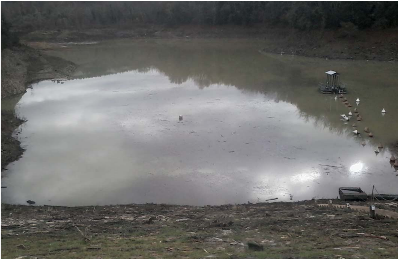
Figura 2-2 – Opera di presa dall'invaso
