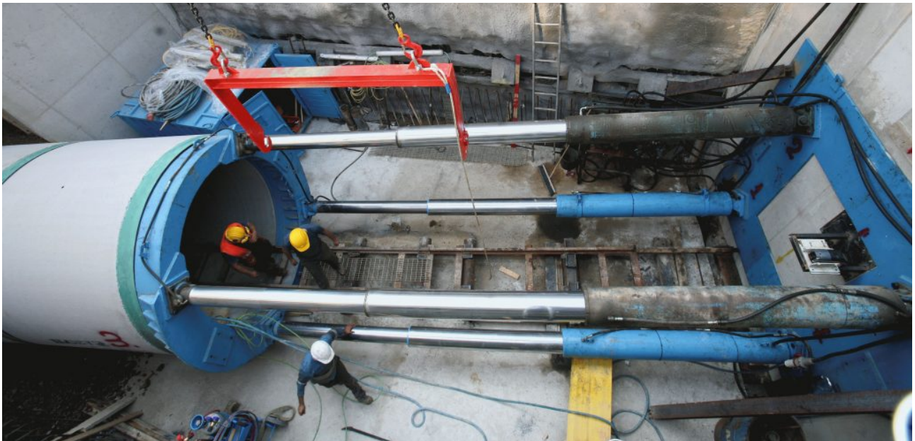
Figura 2.4 – Unità di spinta dotata di piastra metallica fissata al muro di contrasto e quattro pistoni oleodinamici che spingono un anello di spinta con funzione di redistribuire gli sforzi sulla tubazione (foto tratta da http://www.lafalce.it/wp-content/uploads/IMG_4812-1030x687.jpg )
