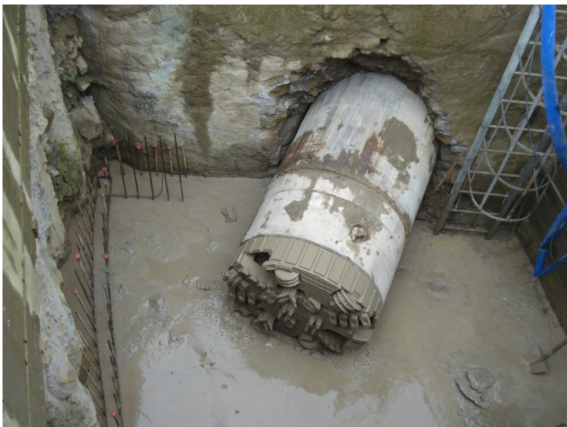
Figura 5.1 – Microtunneler all'interno del pozzo di uscita (tratto dal sito Web La Falce – Posa in opera di condotta in c.a. DI 1600 mm DE 1940 mm – Cliente Co.ge.pa. S.r.l. – Sistema Adduttore Acquedotto Vesuviano).
