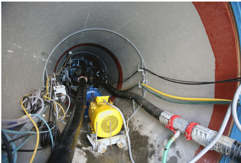
Figura 4.1 – Cavi elettrici ed idraulici di alimentazione fresa. Si noti l'installazione della pompa centrifuga necessaria per l'evacuazione del materiale di smarino.
