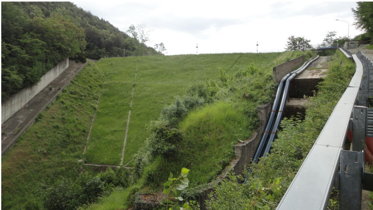
Figura 13 – Passaggio degli scaricatori sullo sfioratore di sinistra
