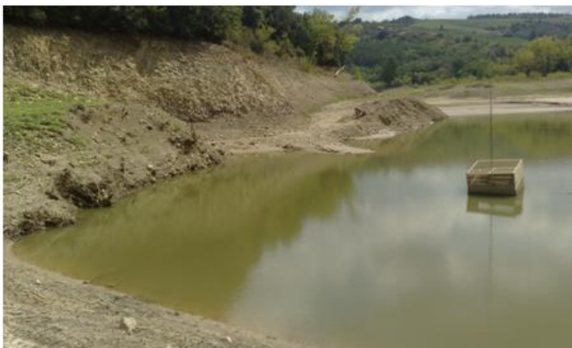
Figura 7 – Opera di presa
