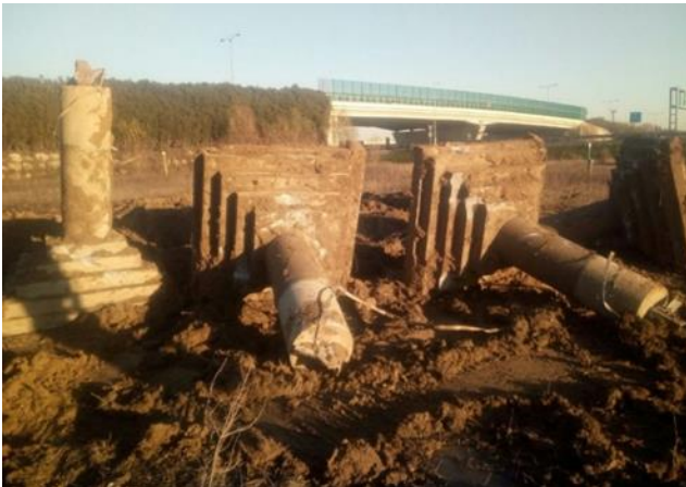
Figura 7.2/3- - Esempio di rimozione della fondazione superficiale di un sostegno 220 kV (a sx) e 380 kV ST (a dx).
