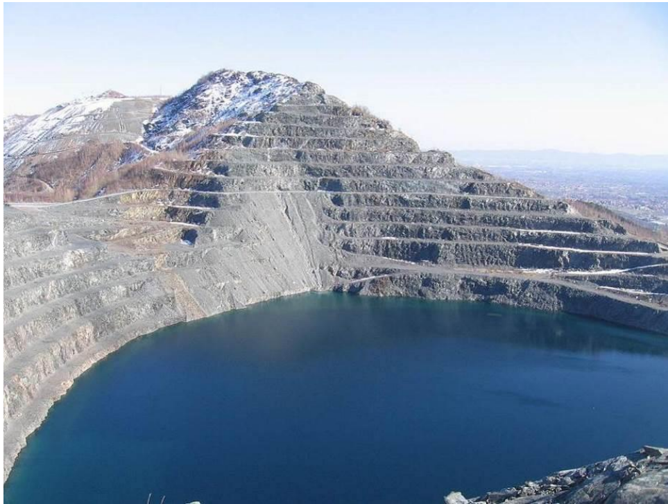
Figura 3.3/4: immagine del lago formatosi con acqua piovana a seguito degli scavi nell'amiantifera
