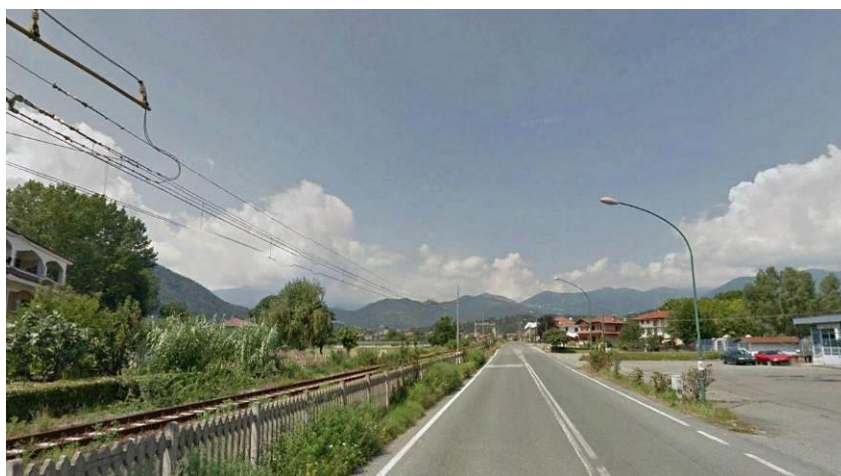
Figura 3.3/1: Sp2 e la linea ferroviaria Torino-Ceres affiancate quali principali infrastrutture di trasporto nell'ambito considerato
