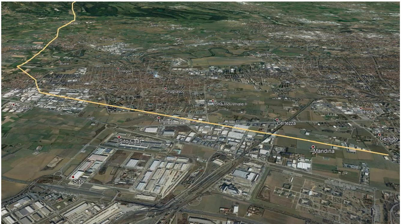
Figura 3.1/9: vista a volo d'uccello del finale di linea oggetto di dismissione lungo le aree industriali del comune di Grugliasco e della periferia nord di Torino (in giallo la linea di prevista demolizione)
