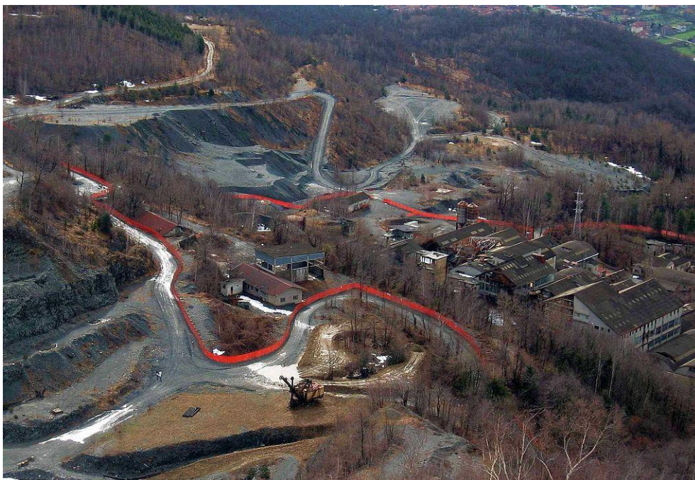
Figura 3.3/5: viabilità all'interno dell'amiantifera ed impianti connessi
