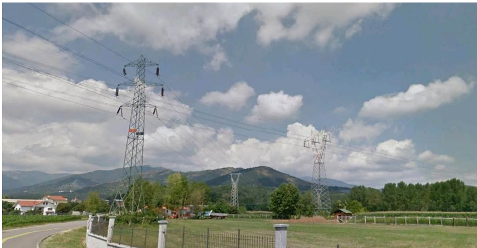
Figura 3.4/29: fitta rete di elettrodotti presente nell'area vasta
