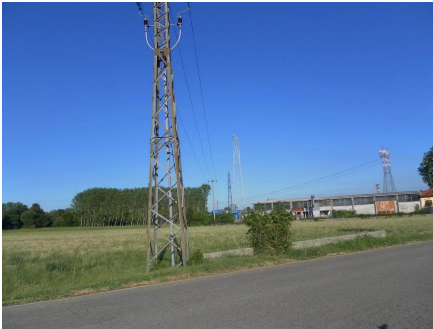
Figura 3.3/2: la presenza di linee elettriche nell'area di intervento quali elemento caratterizzante il paesaggio
