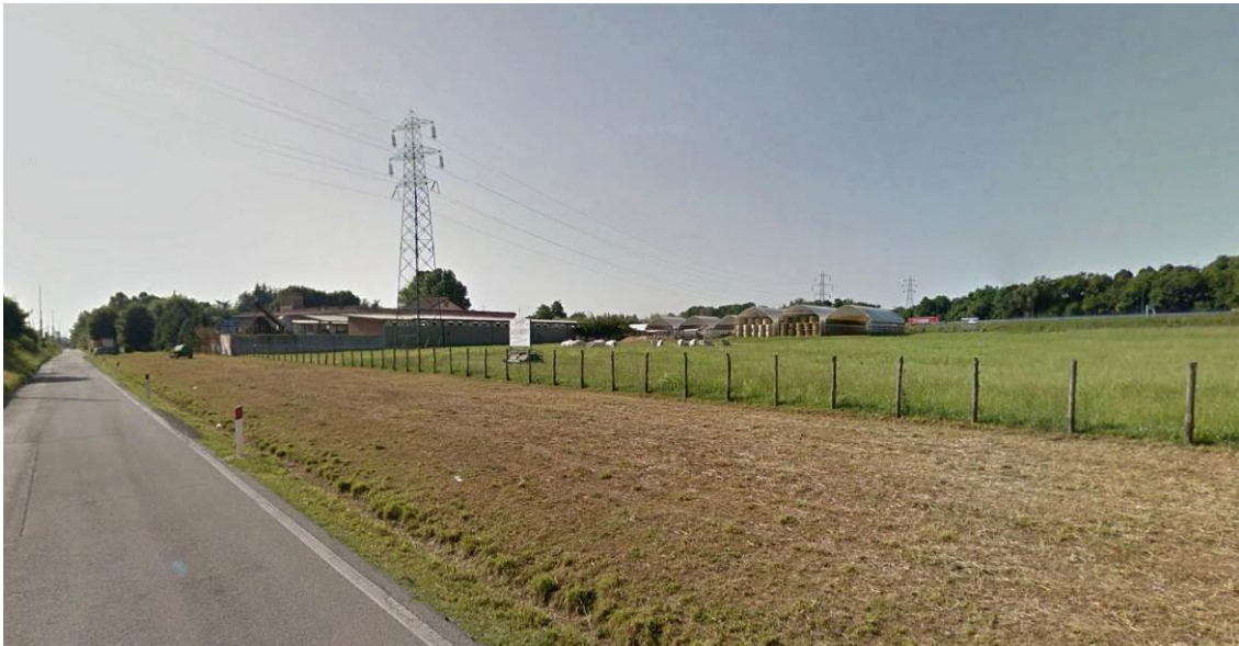
Figura 3.3/9: la linea di prevista dismissione in attraversamento del corridoio della tangenziale visibile sullo sfondo delimitato da fascia boscata
