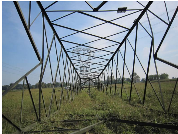
Figura 7.2/1: Fasi demolizione di un sostegno a traliccio
