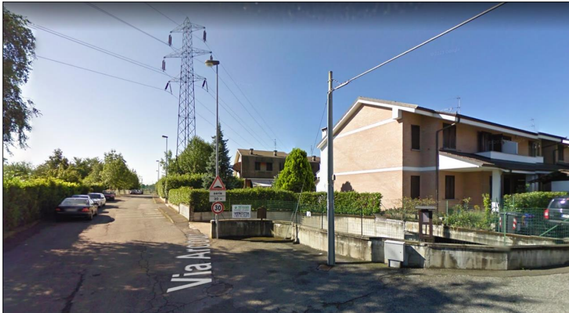
Figura 6.2/3: fronti visuali a nord di Fiano, su via Arcour, interessati dalla dominanza visuale del sostegno della linea di prevista dismissione
