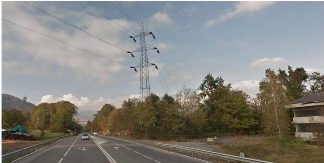
Figura 6.2/10: dominanza visuale della linea di prevista dismissione sulla SP 1 delle Valli di Lanzo a Fiano
