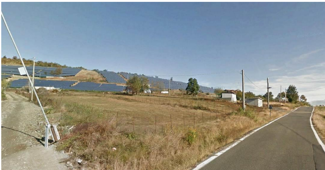
Figura 3.3/6: il parco fotovoltaico dalla strada provinciale SP 27.
