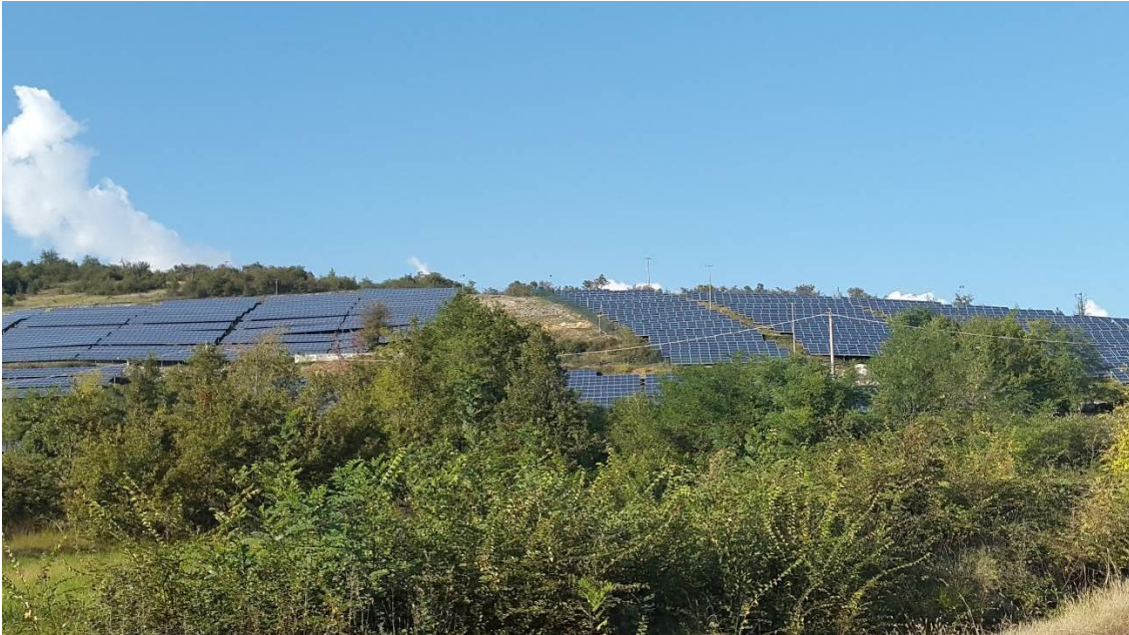
Figura 3.4/30: impianto fotovoltaico sul versante Sud del Monte Giovetto quale elemento detrattore
