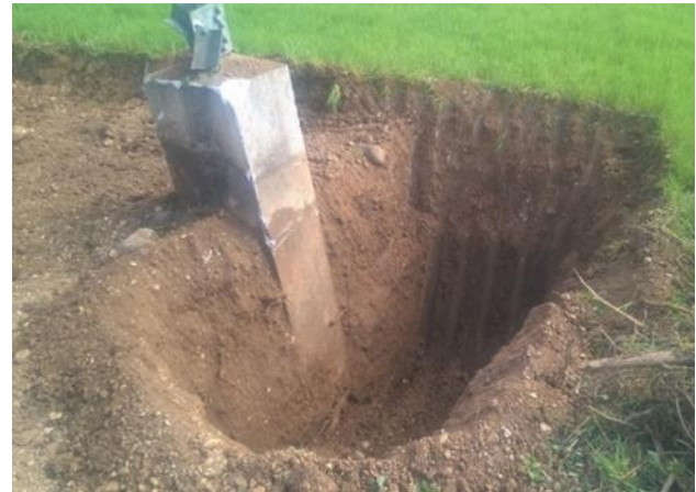
Figura 7.2/3- - Esempio di rimozione della fondazione superficiale di un sostegno 220 kV (a sx) e 380 kV ST (a dx).
