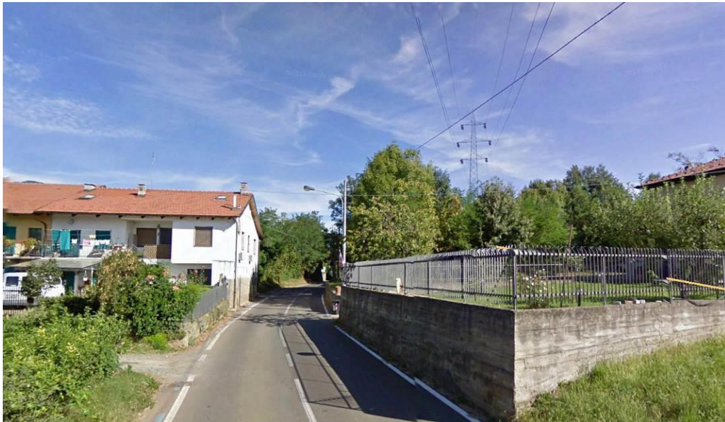
Figura 3.4/5: ambito esterno ai centri abitati localizzato lungo via Rossini in comune di Fiano, è visibile la linea di prevista demolizione
