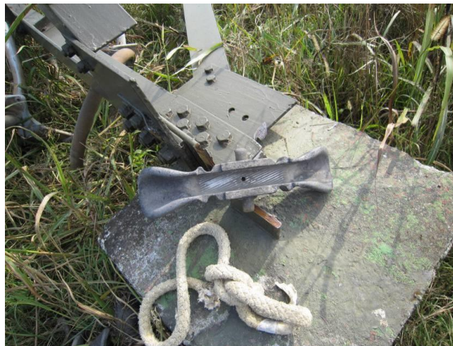
Figura 7.2/2- Fasi demolizione di un sostegno a traliccio, particolare di materiale raccolto
