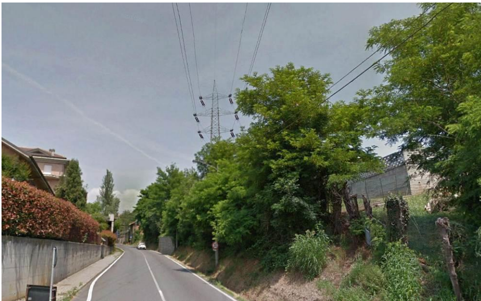
Figura 3.4/2: visibilità della linea oggetto di dismissione dal limite del centro storico di San Gillio
