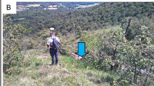
A – Area di fondazione nuovo sostegno (freccia rossa). Substrato roccioso affiorante. B - Rio con limitato trasporto solido (freccia azzurra)
