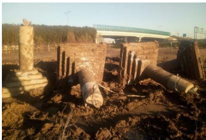
Figura 4.2/3 - Esempio di rimozione della fondazione superficiale di un sostegno 220 kV (a sx) e 380 kV ST (a dx).
