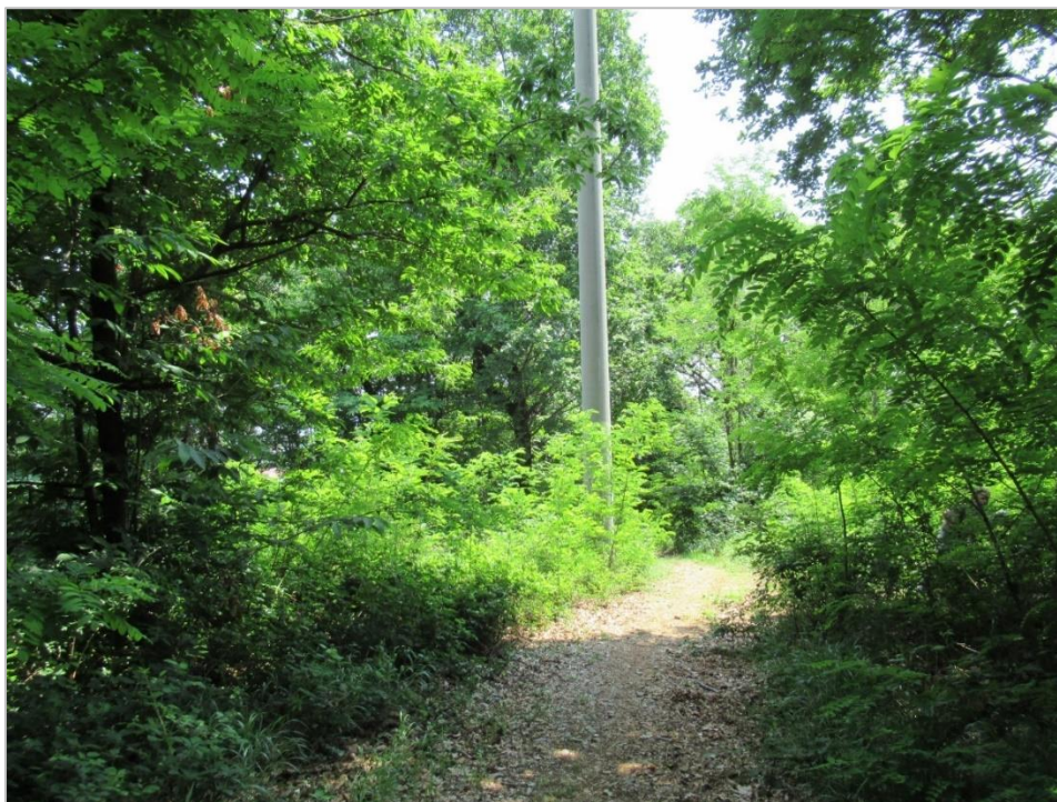
Figura 2.2.2/12 - Vista della pista in corrispondenza del palo della linea a media tensione
