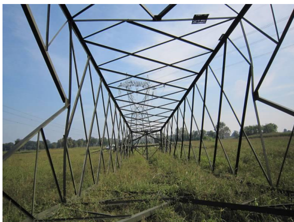
Figura 4.2/1 - Fasi demolizione di un sostegno a traliccio
