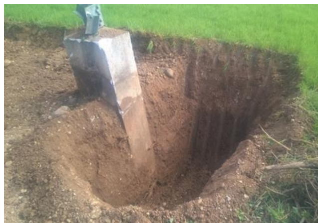
Figura 4.2/3 - Esempio di rimozione della fondazione superficiale di un sostegno 220 kV (a sx) e 380 kV ST (a dx).
