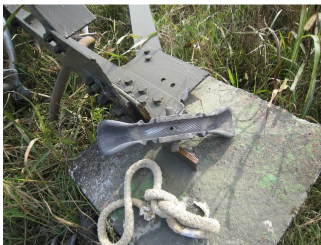
Figura 4.2/2 - Fasi demolizione di un sostegno a traliccio, particolare di materiale raccolto
