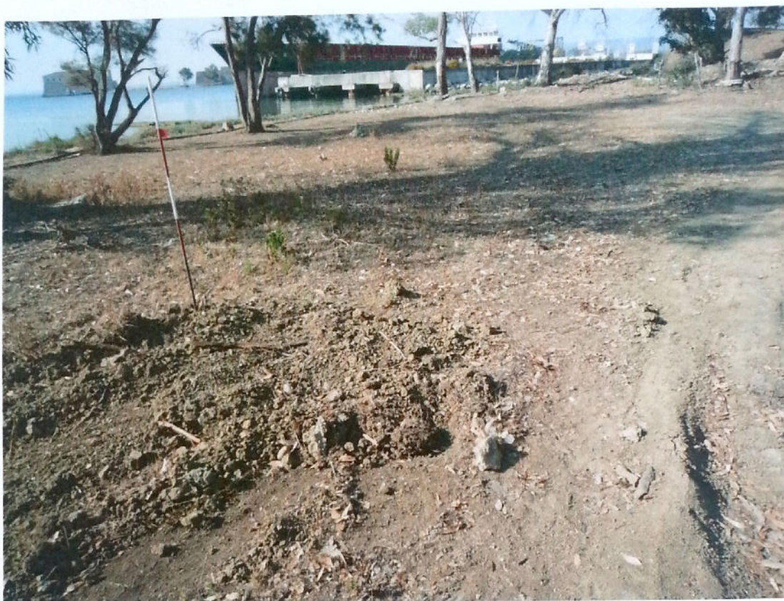
Foto n.5 – Zona cantiere lato banchine esistenti
