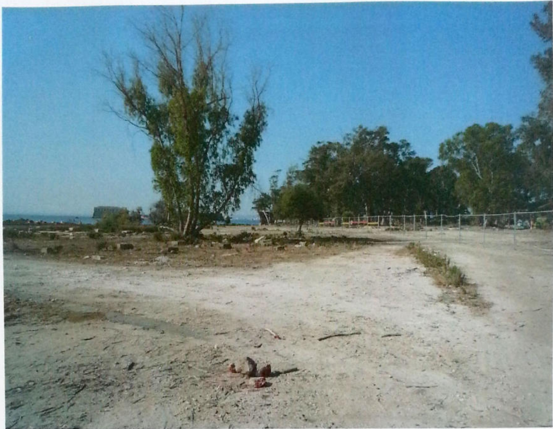
Foto n.3 - Zona centrale del cantiere
