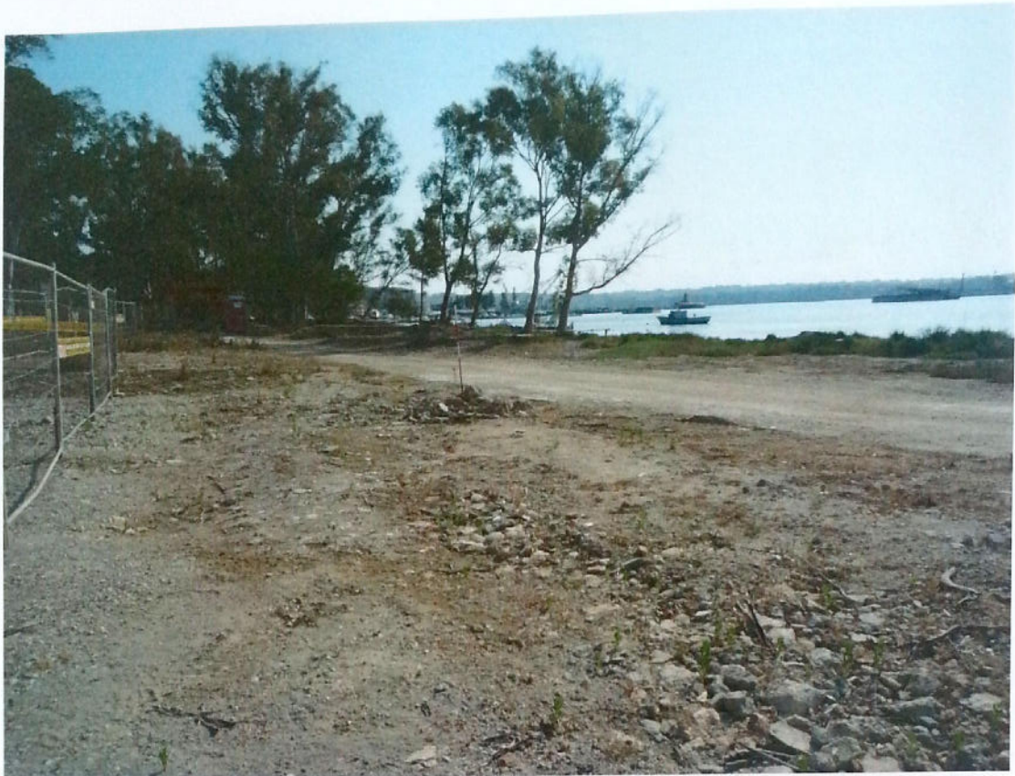
Foto n.1 - Zona ingresso cantiere
