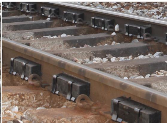
Ammortizzatori Van Uuden (Foto: Van Uuden, 2012)
