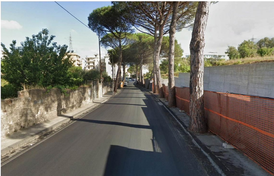
Foto 1: Tratto di strada del nuovo tracciato in cavo di Via San Renato.
