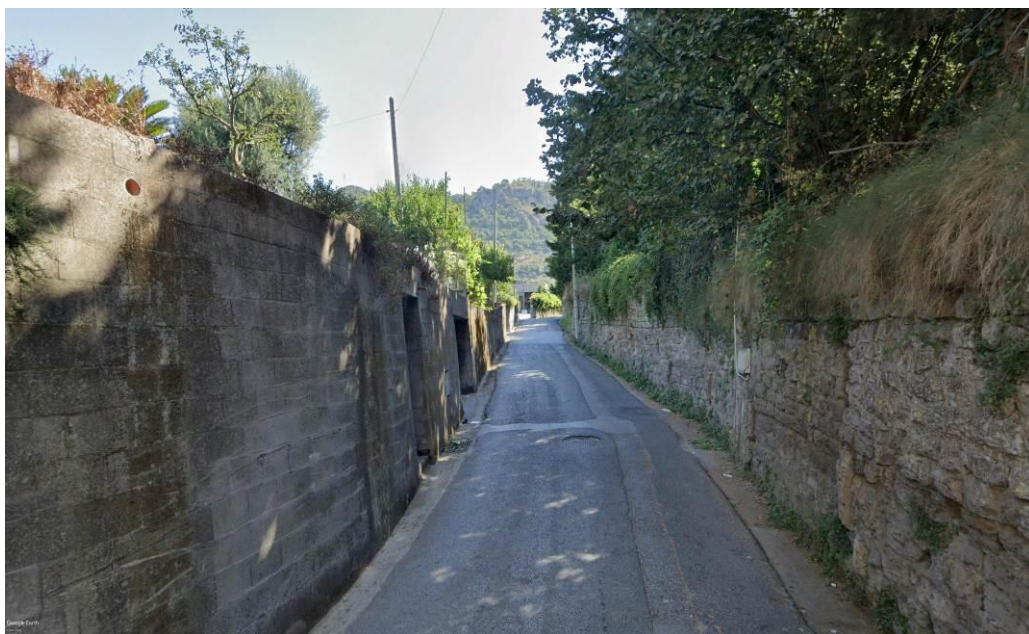
Foto 10: Via Lavinola posa in teleguidato
