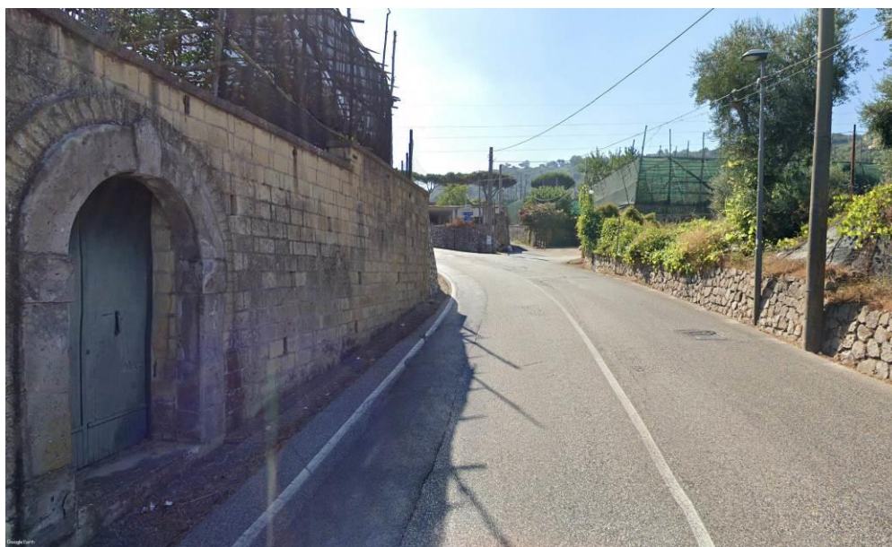
Foto 6: Strada Provinciale Mortora S.Liborio – incrocio Via Pomicino
