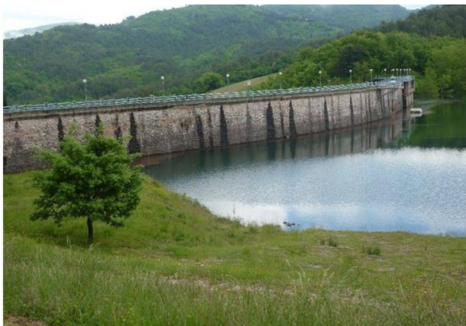
Figura 24. Vista dello sbarramento da monte (fonte Consorzio di Bonificazione Umbra)
